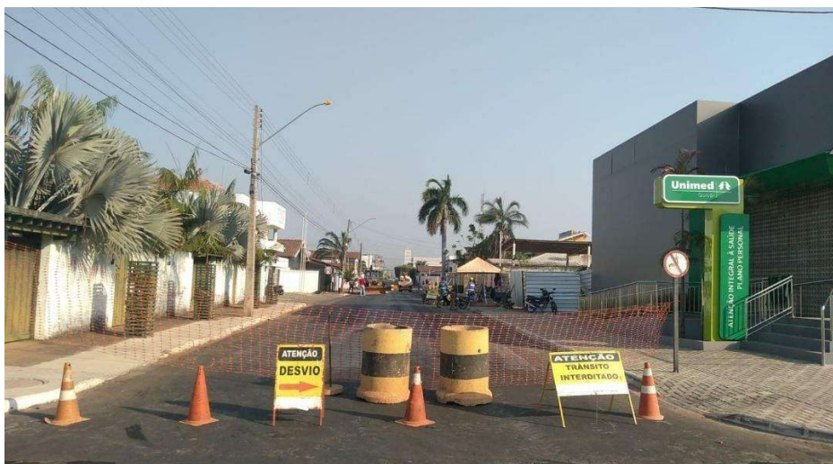
Figura 13 - EPCs para isolamento de área de risco.
