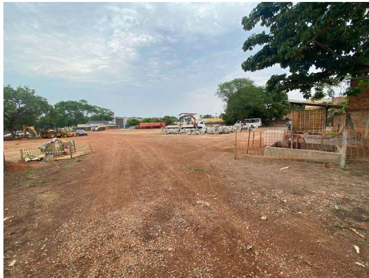
Figura 8 - Canteiro de obras.
