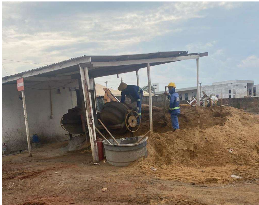
Figura 11 - Trabalhadores usando EPI's manuseando betoneira.
