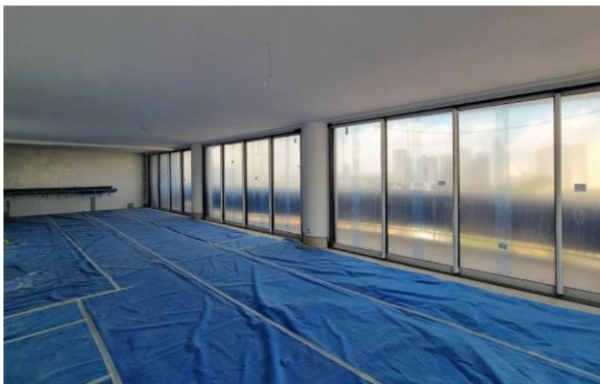
Figura 36: Proteção do piso
