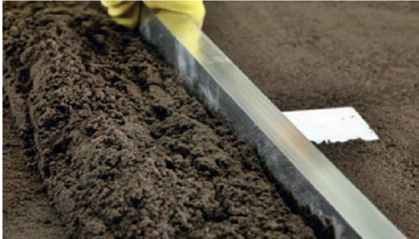
Figura 32: Farofa, para execução do contrapiso
