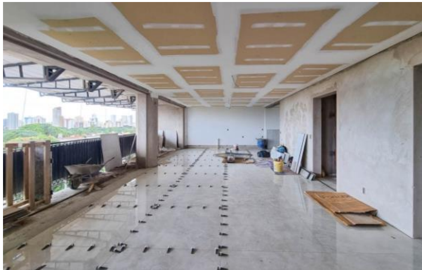
Figura 35: Execução do porcelanato
