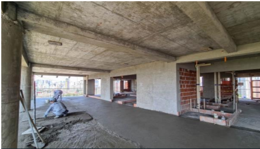
Figura 33: Execução do contrapiso
