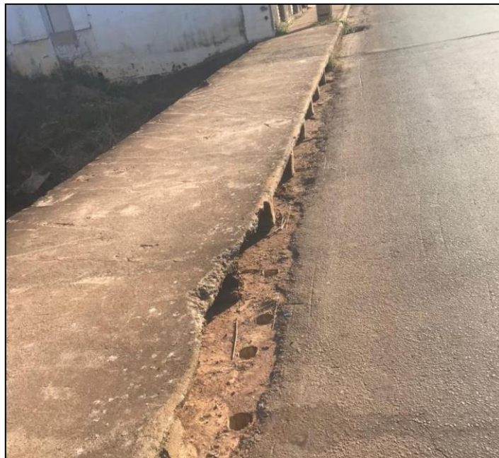
Figura 12 – Boca de lobo 2
