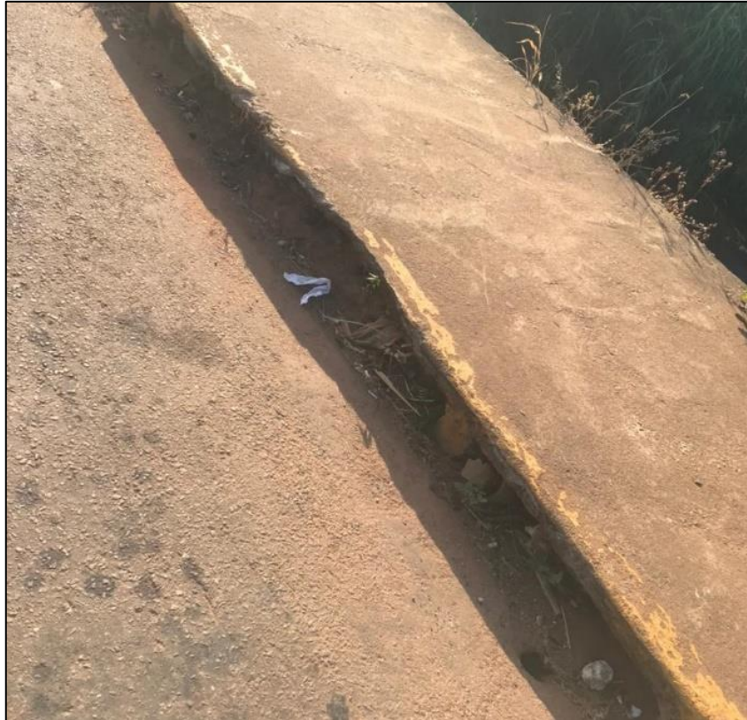
Figura 13 – Boca de lobo 3
