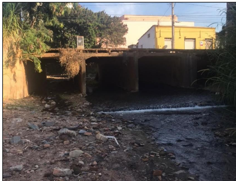
Figura 15 – Galeria de concreto
