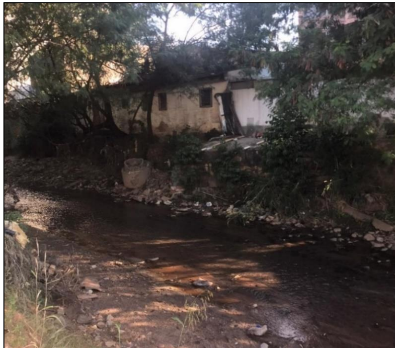
Figura 6 - Edificações a margem do rio Góis
