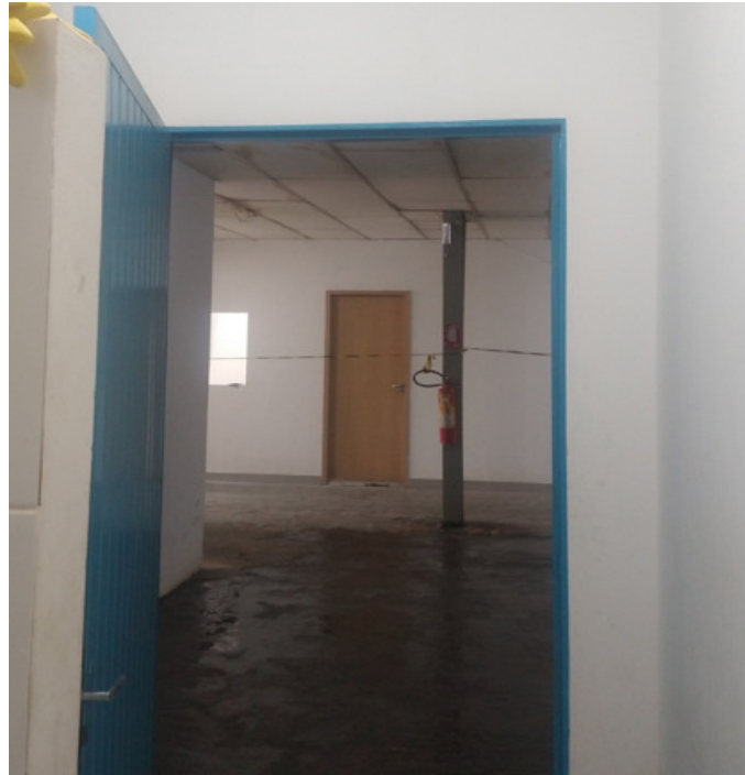
FIGURA 12: BANHEIRO MASCULINO SECRETARIA DE OBRAS DE ANÁPOLIS
