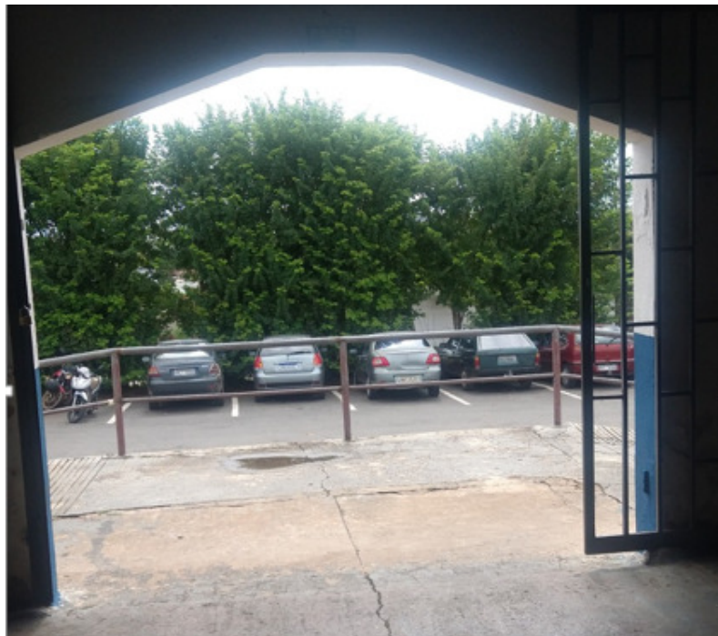
FIGURA 11: SAÍDA DE EMERGÊNCIA SECRETARIA DE OBRAS DE ANÁPOLIS
