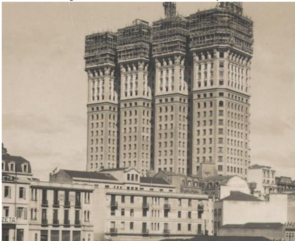
Figura 5 - Edifício Martinelli durante sua construção.
