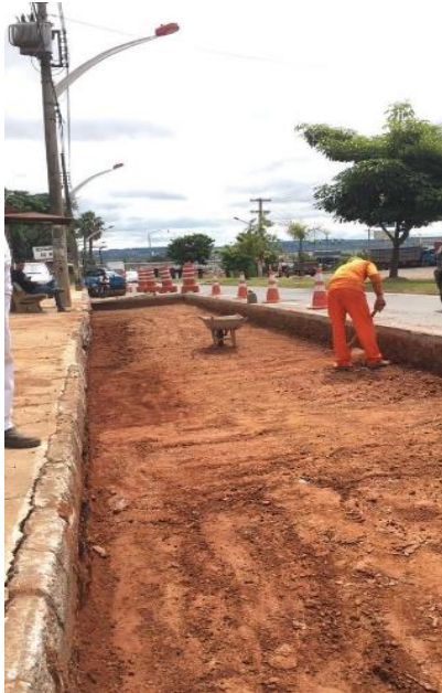
Figura 09 - Retirada do Pavimento antigo.
