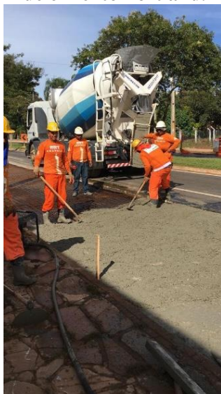
Figura 17 - Fase da concretagem – emprego de cimento Portland.
