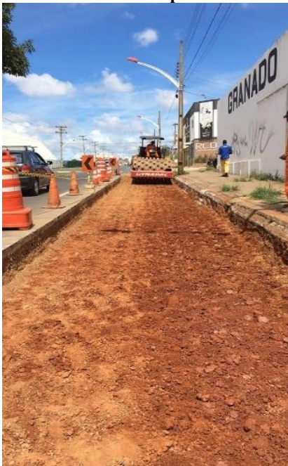
Figura 11 - Compactação do subleito com rolo de pé de carneiro.
