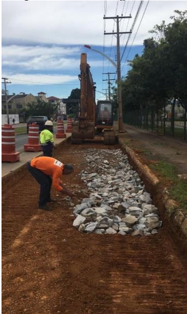
Figura 13 - Sub-base, sendo espalhado brita graduada.
