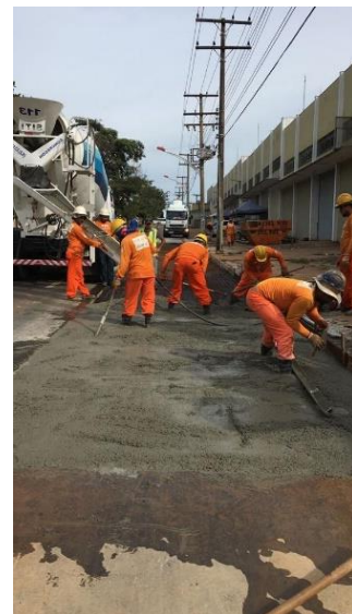
Figura 18 - Emprego de cimento Portland.
