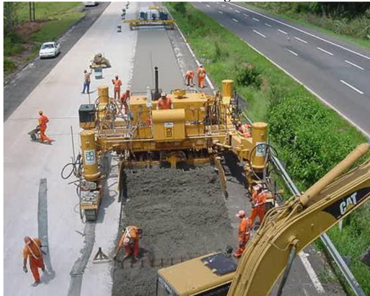
Figura 07 - Etapa de Lançamento do Concreto na Execução do Pavimento Rígido.
