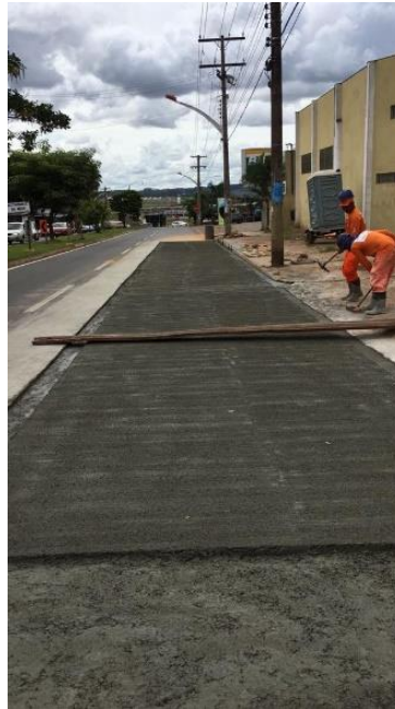
Figura 19 - Introdução de ranhuras ao Pavimento.
