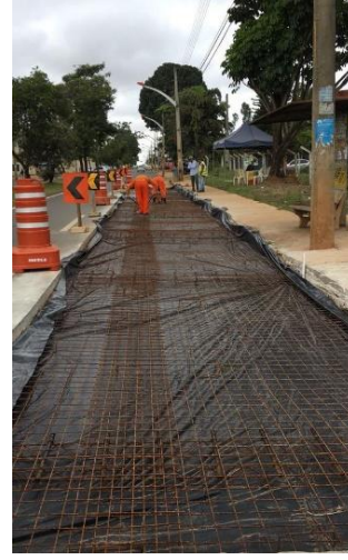
Figura 16 - Introdução de barras de aços de transição e de ligação.
