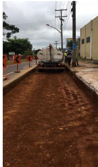
Figura 12 - Umectação do solo.
