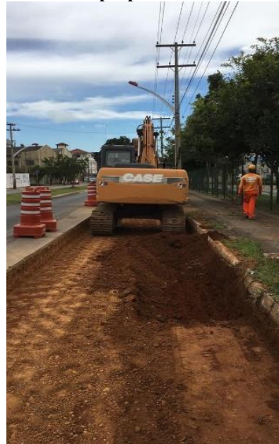
Figura 10 - Camada de subleito utilizando cascalho graúdo espalhado com uma máquina apropriada.
