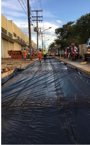
Figura 15 - Adição da manta geotêxtil para impermeabilização do solo.
