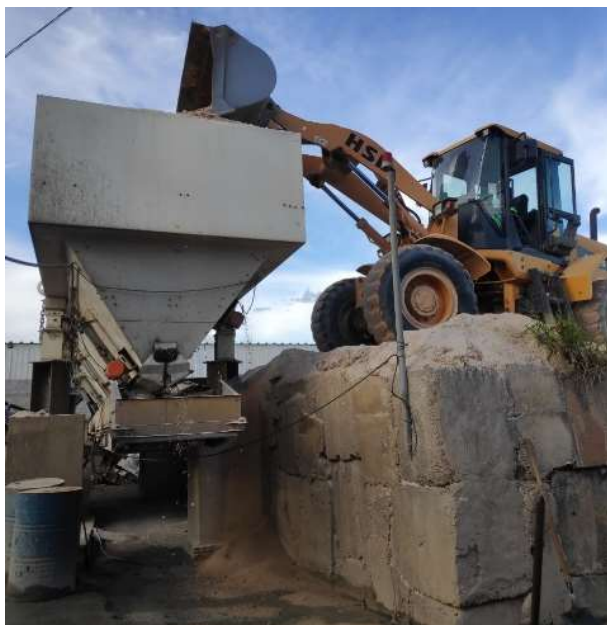
Figura 19 - Dosagem da areia com uma pá carregadeira
