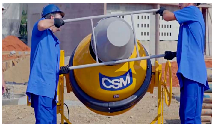
Figura 4 - Argamassa preparada na obra
