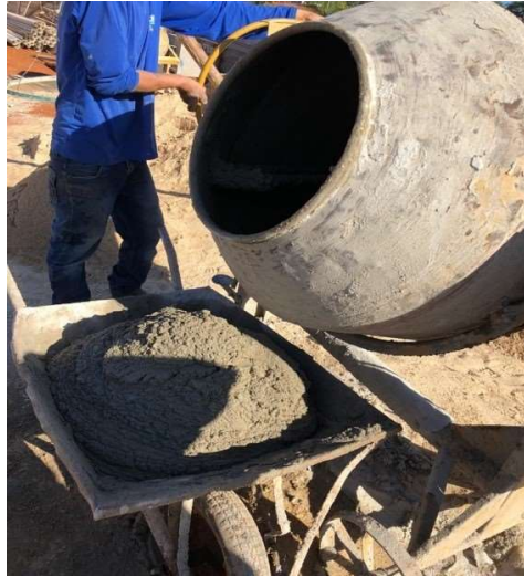
Figura 12 - Argamassa in loco finalizada
