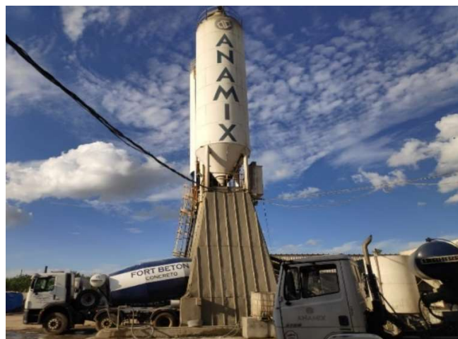
Figura 18 - Abastecimento do caminhão betoneira
