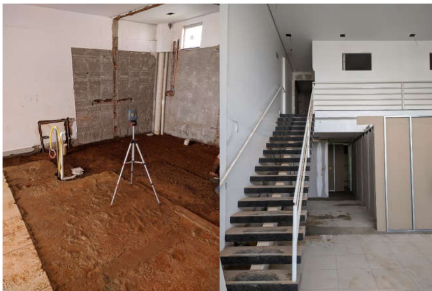
Figura 12 - Obra reforma studio na Galeria Gildo Porto.
