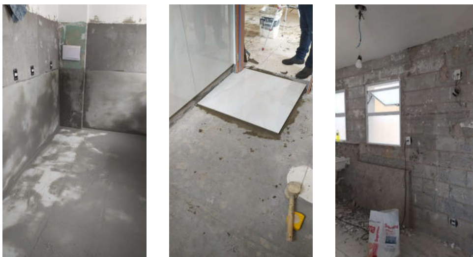
Figura 11 - Obra de reforma apartamento no Residencial Vale Verde.
