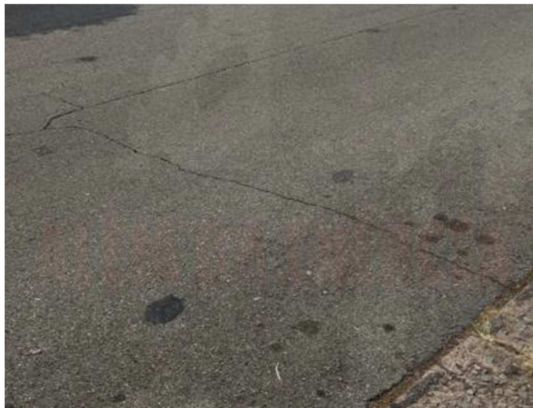
Figura 10 – Trinca transversais
