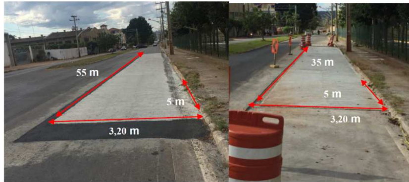
Figura 35: Geometria e extensão das placas de concreto.
