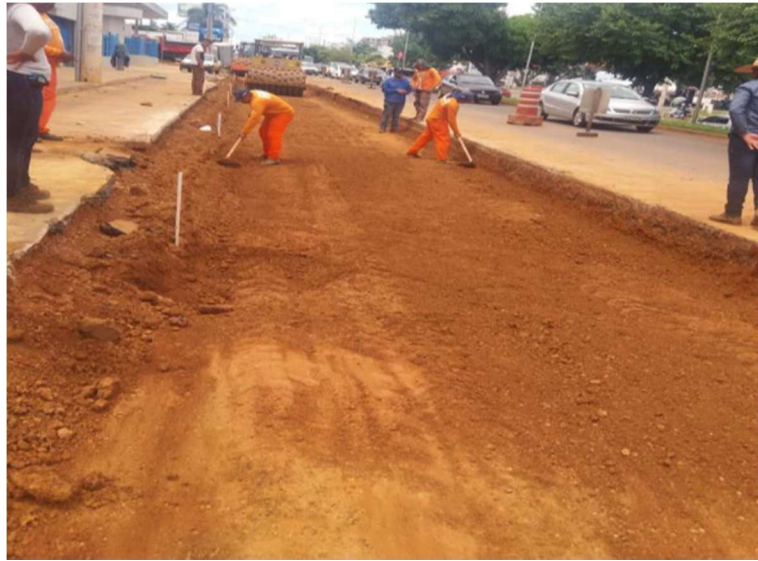
Figura 29: Construção de Subleito Av. Brasil Norte
