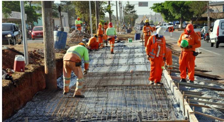
Figura 28: confecção de lajes armadas de concreto na plataforma de parada de ônibus
