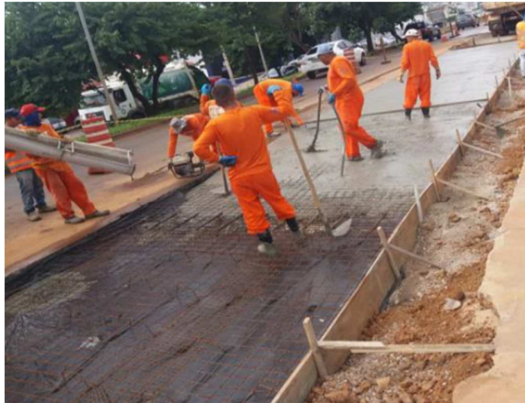
Figura 33: Fase de concretagem
