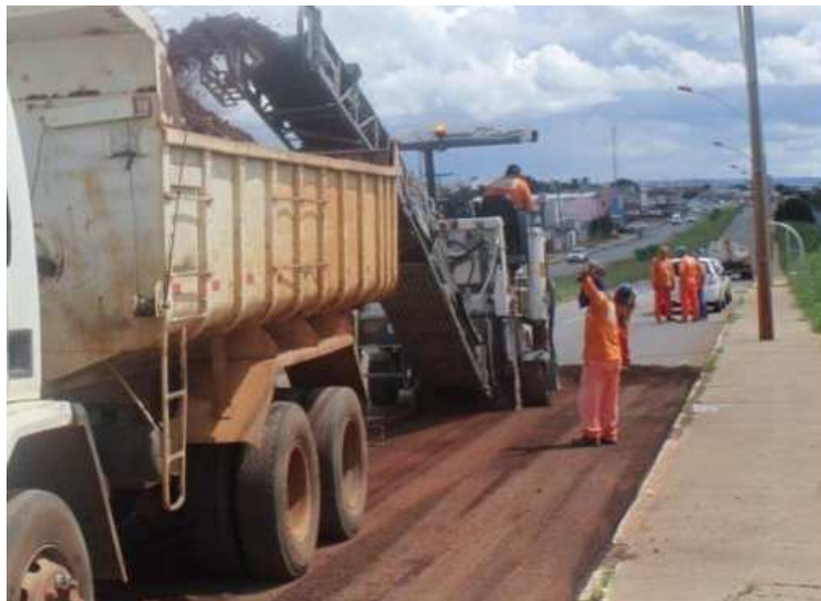
Figura 30: Construção Subleito Av. Pedro Ludovico
