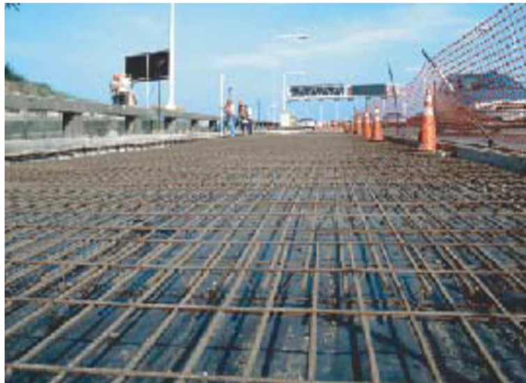
Figura 17: Armadura da Ponte Rio Niterói – RJ
