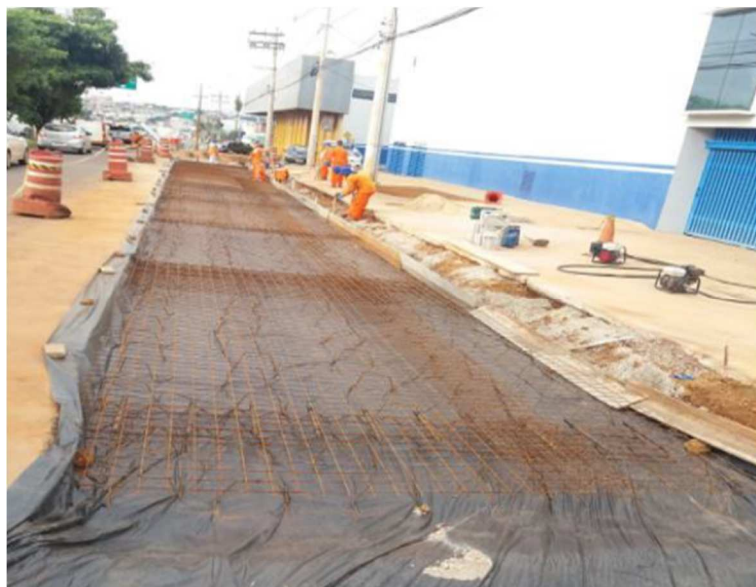
Figura 32: Aplicação de manta e barras de aço.
