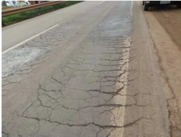
Figura 24: BR-163/MT Jaciara antes da restauração utilizando o método whitetopping:
