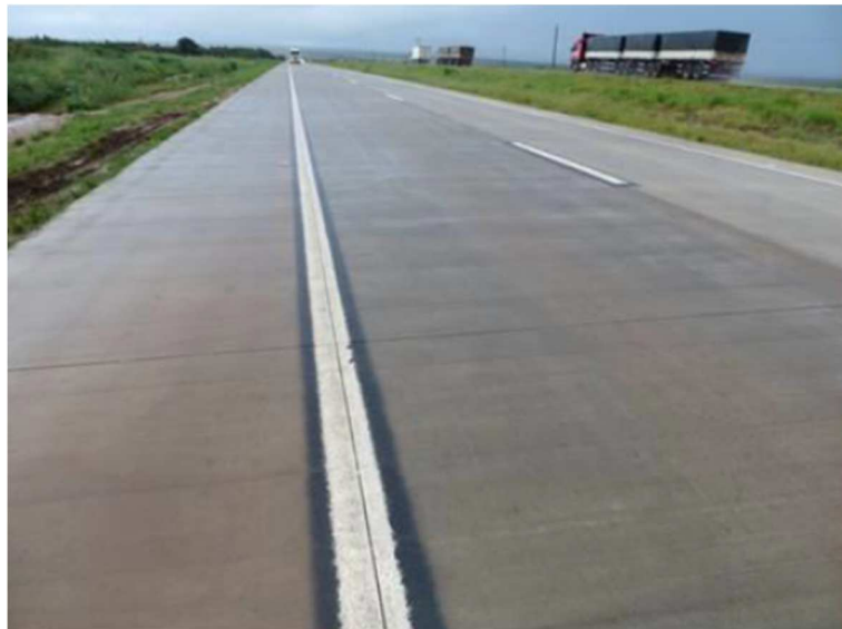
Figura 25: BR-163/MT Jaciara após a restauração utilizando o método whitetopping:
