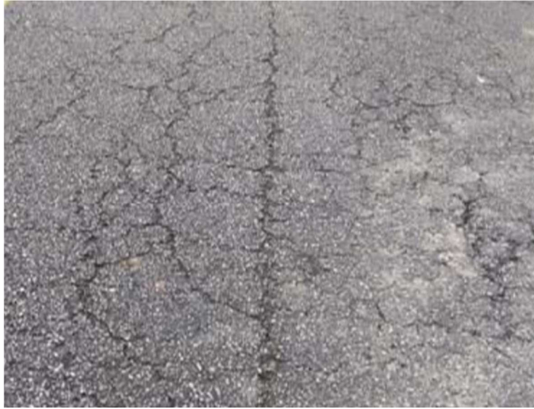
Figura 11 – Trincas longitudinais
