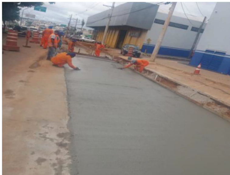
Figura 34: Acabamento após concretagem
