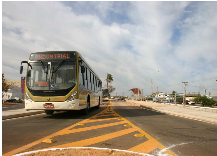
Figura 36: Corredor de ônibus Avenida Brasil Sul.
