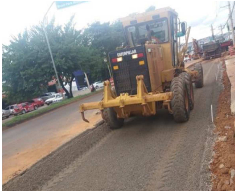
Figura 31: Construção da Sub-base
