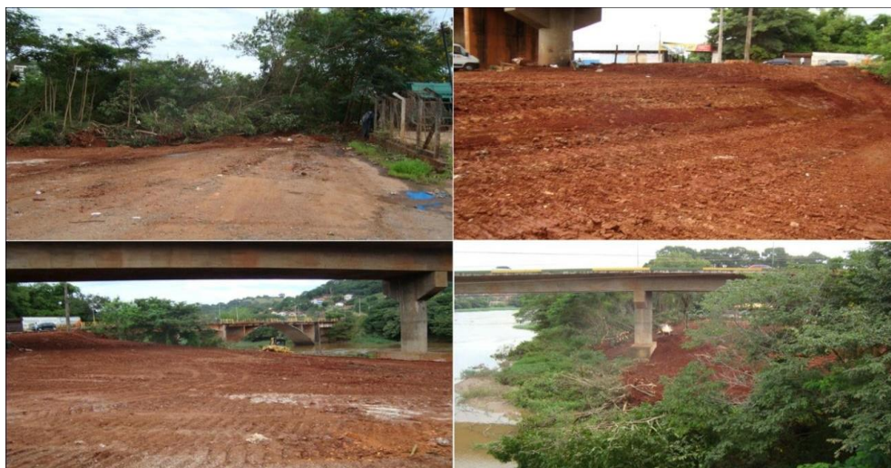
Figura 24. Degradação ambiental em Área de Preservação Permanente do Rio das Almas entre os municípios de Rialma e Ceres, com supressão da mata ciliar.
