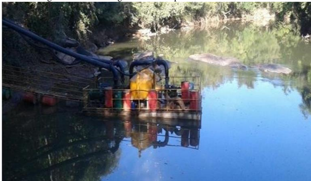
Figura 4. Registro de equipamento captando água no rio das Almas para irrigar canaviais na região do município de Carmo de rio Verde.
