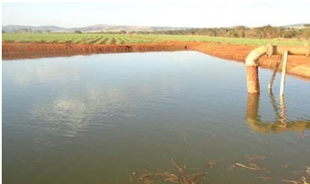
Figura 5. Bomba instalada para captar água do rio das Almas e armazenar em área de uma usina sucroalcooleira próxima ao município de Ceres/GO.
