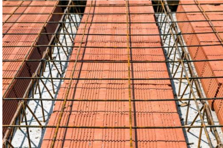
Figura 4 – Laje nervurada treliçada pronta para receber o concreto.
