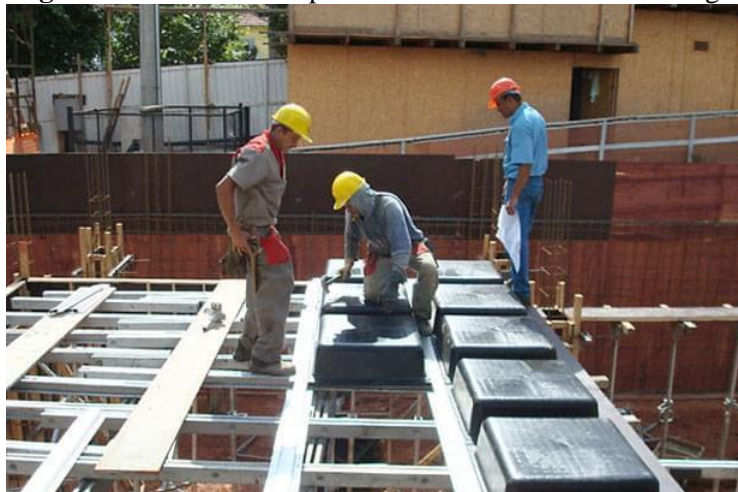
Figura 2 – Processo de apoio das cubas direto nas vigas
