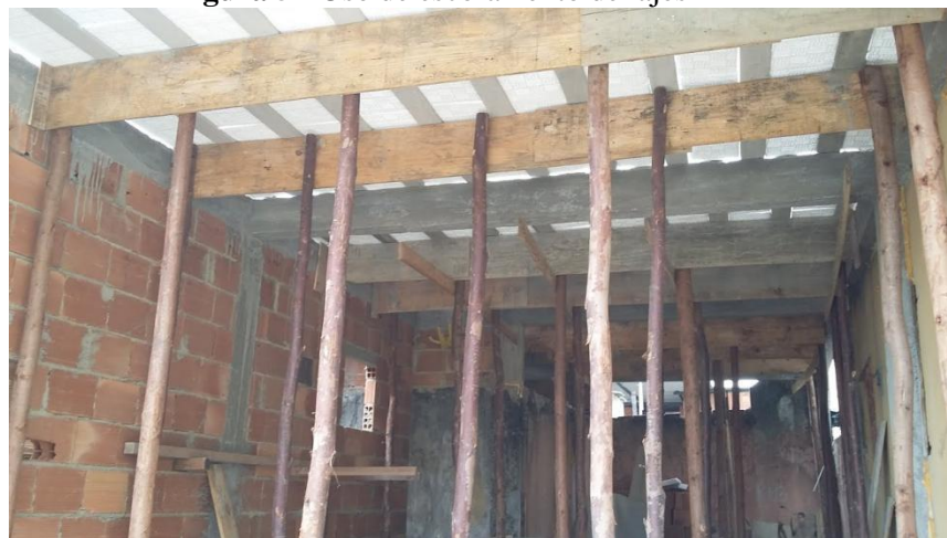
Figura 5 - Uso de escoramento de lajes
