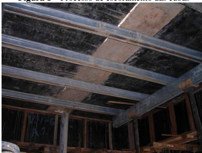
Figura 1 – Processo de escoramento das cubas
