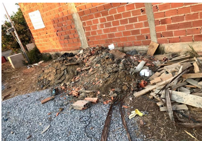
Figura 5 – Disposição resíduos de demolição
