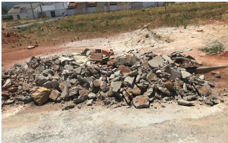
Figura 9 – Restos de demolição
