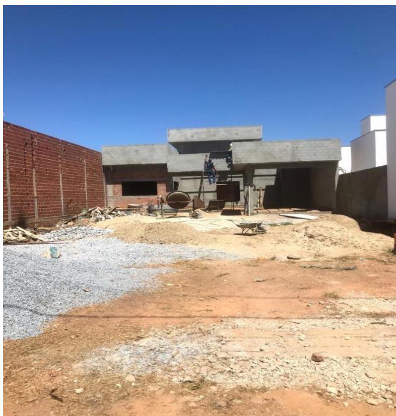
Figura 3 – Canteiro de obras
