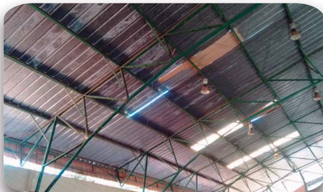
Foto 4 – Desgaste ocasionado pela umidade e calor excessivos
