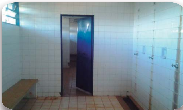
Foto 7 – Porta de um dos banheiros
