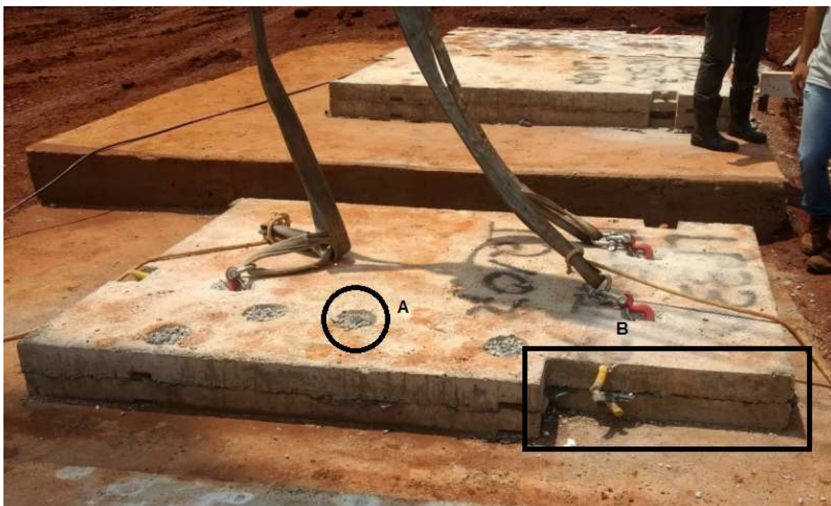
Figura 30: A- abertura da tubulação sanitária B- abertura dos shafts
