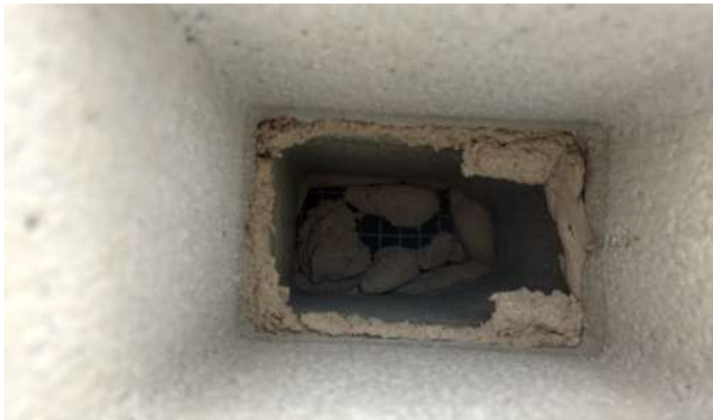
Figura 22: Imagem da tela no interior da parede
