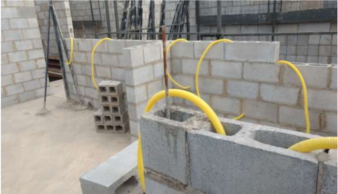
Figura 36: Eletrodutos instalados nos vãos dos blocos
