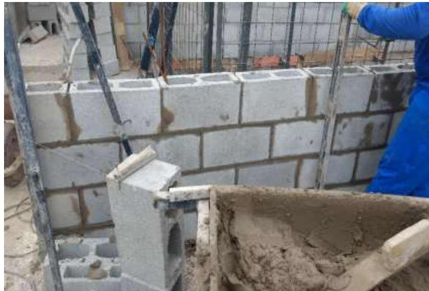
Figura 14: Profissional conferindo o prumo da parede
