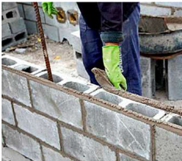
Figura 12: Aplicação da argamassa com a utilização da palheta
