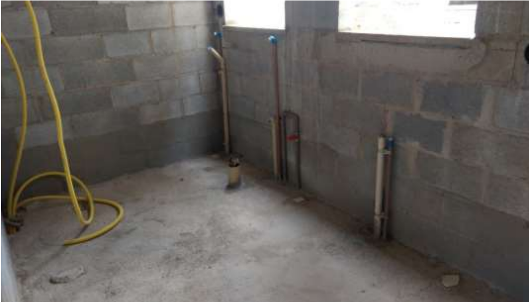
Figura 41: Tubulação sanitária e hidráulica da cozinha e lavanderia, acima da laje
