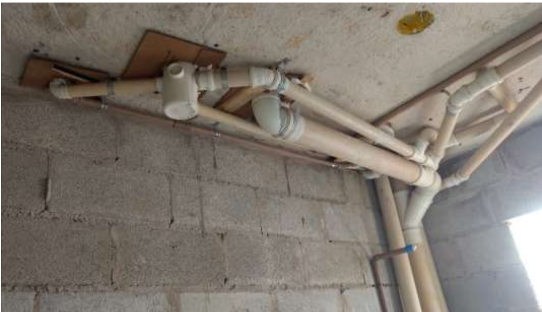
Figura 40: Tubulação sanitária e hidráulica do banheiro, abaixo da laje
