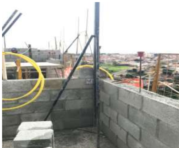
Figura 10 : Escantilhão no canto da parede, servindo como gabarito.
