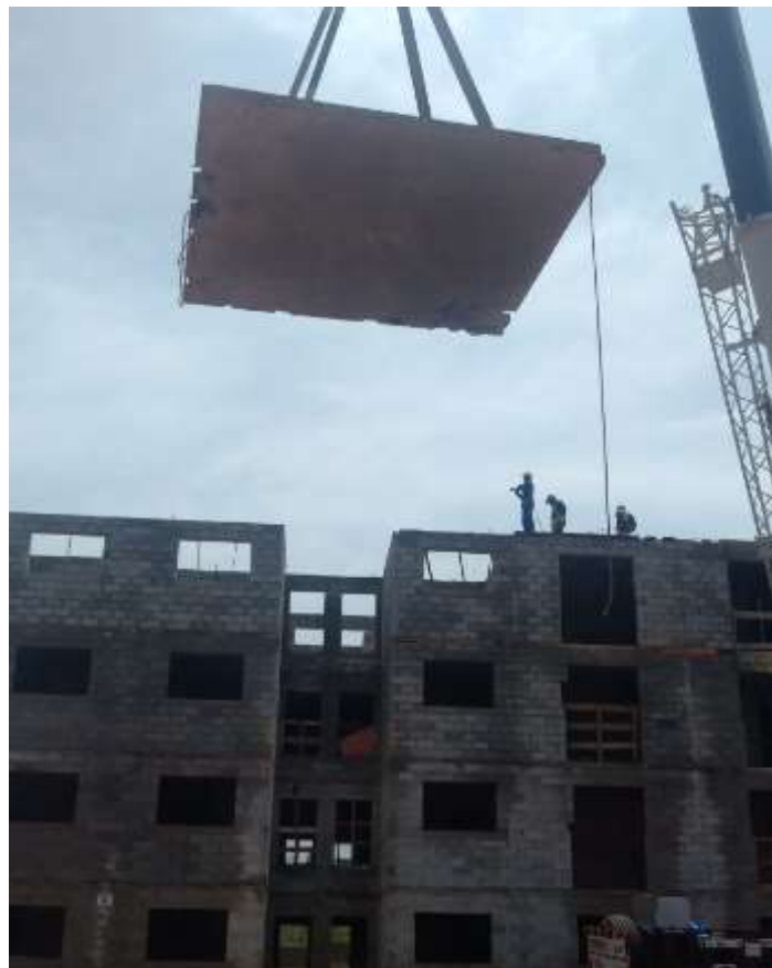
Figura 32: Guindaste içando a laje até o seu local de destino.
