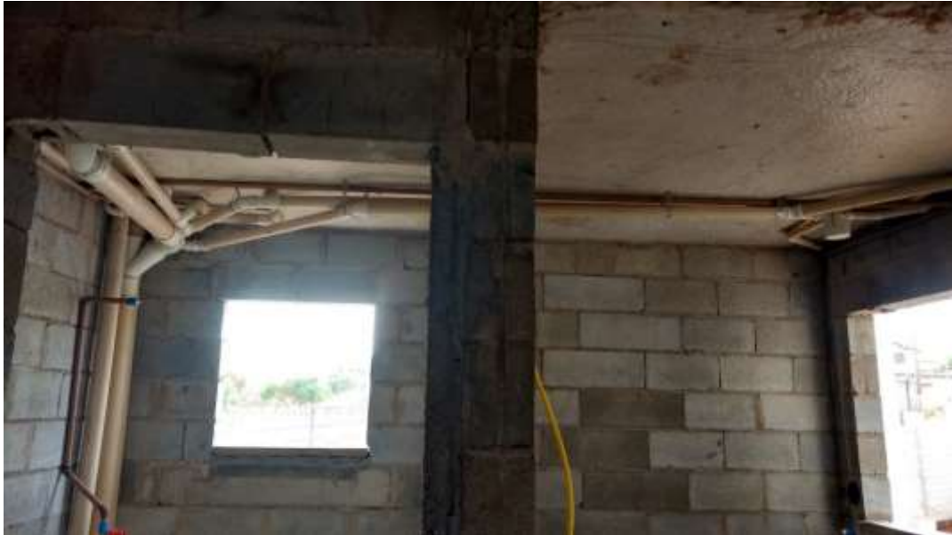
Figura 43: Tubulação sanitária e hidráulica, do banheiro, cozinha e lavanderia
