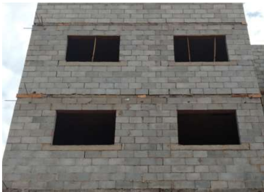
Figura 15: Escoramento realizado na verga das janelas
