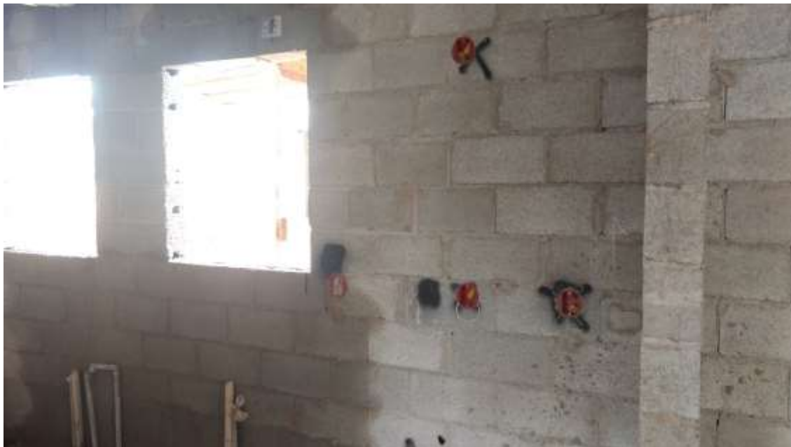
Figura 38: Aberturas realizadas na cozinha, para instalação de tomadas e interruptores
