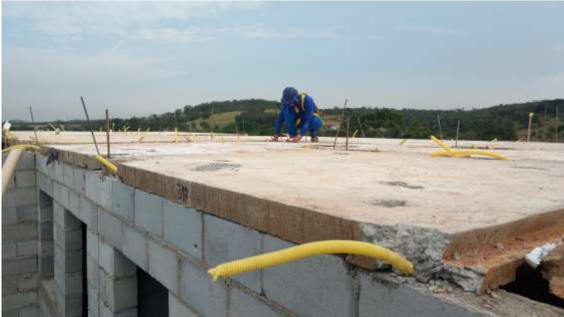
Figura 33: Lajes posicionadas
