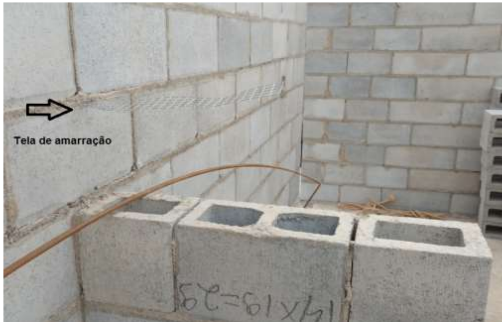
Figura 21: Tela utilizada para fazer a amarração da parede sem função estrutural
