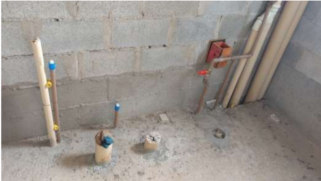
Figura 39: Tubulação sanitária e hidráulica do banheiro, acima da laje
