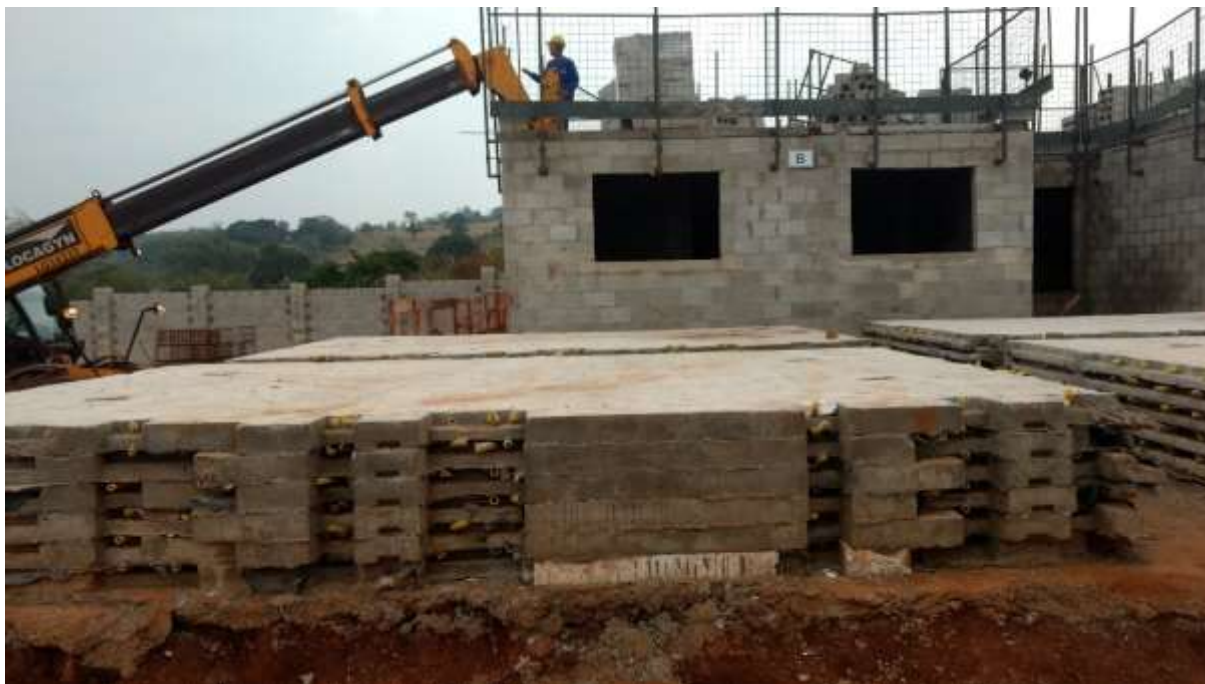
Figura 6 : Laje maciça pré-fabricada
