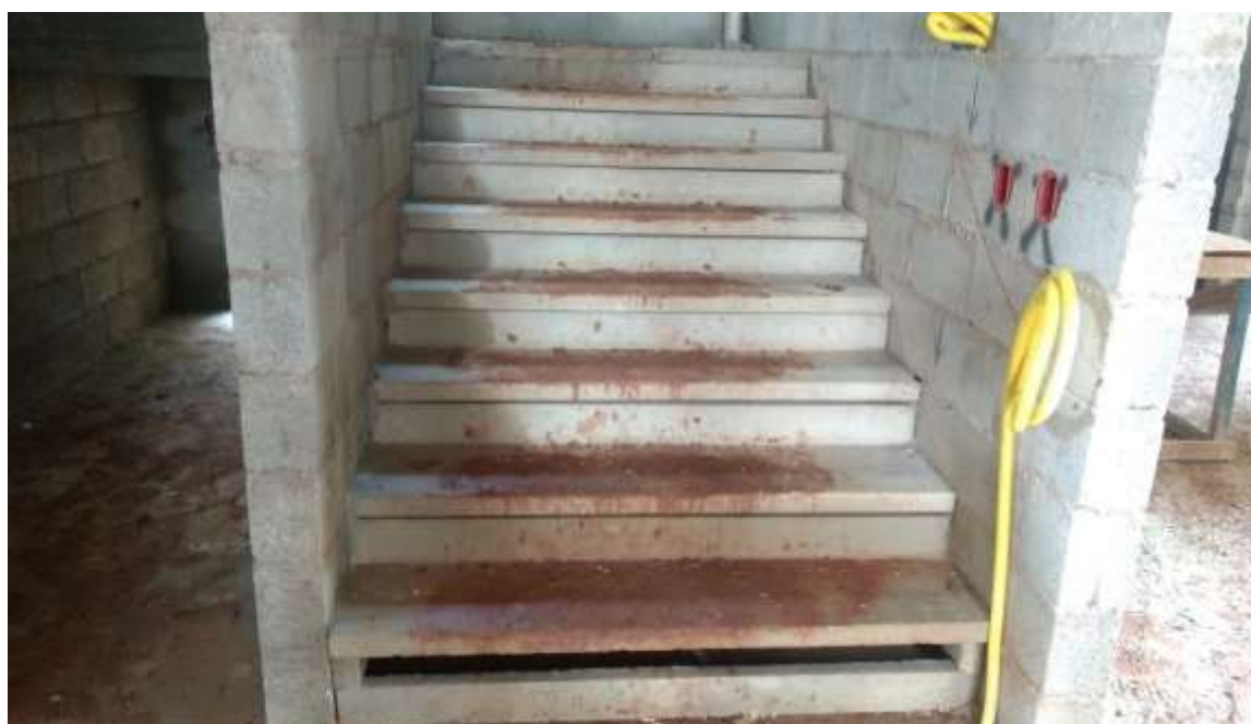
Figura 29: Degraus em L, fixados na viga jacaré
