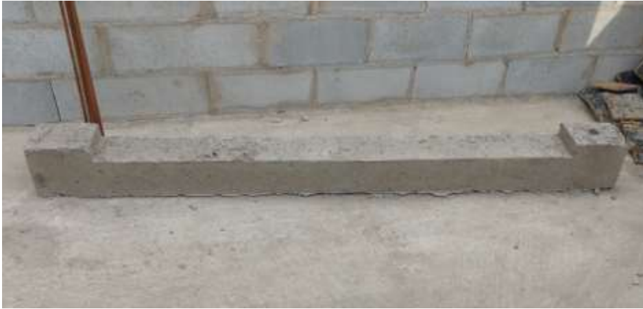
Figura 16: contra-verga pré-moldada
