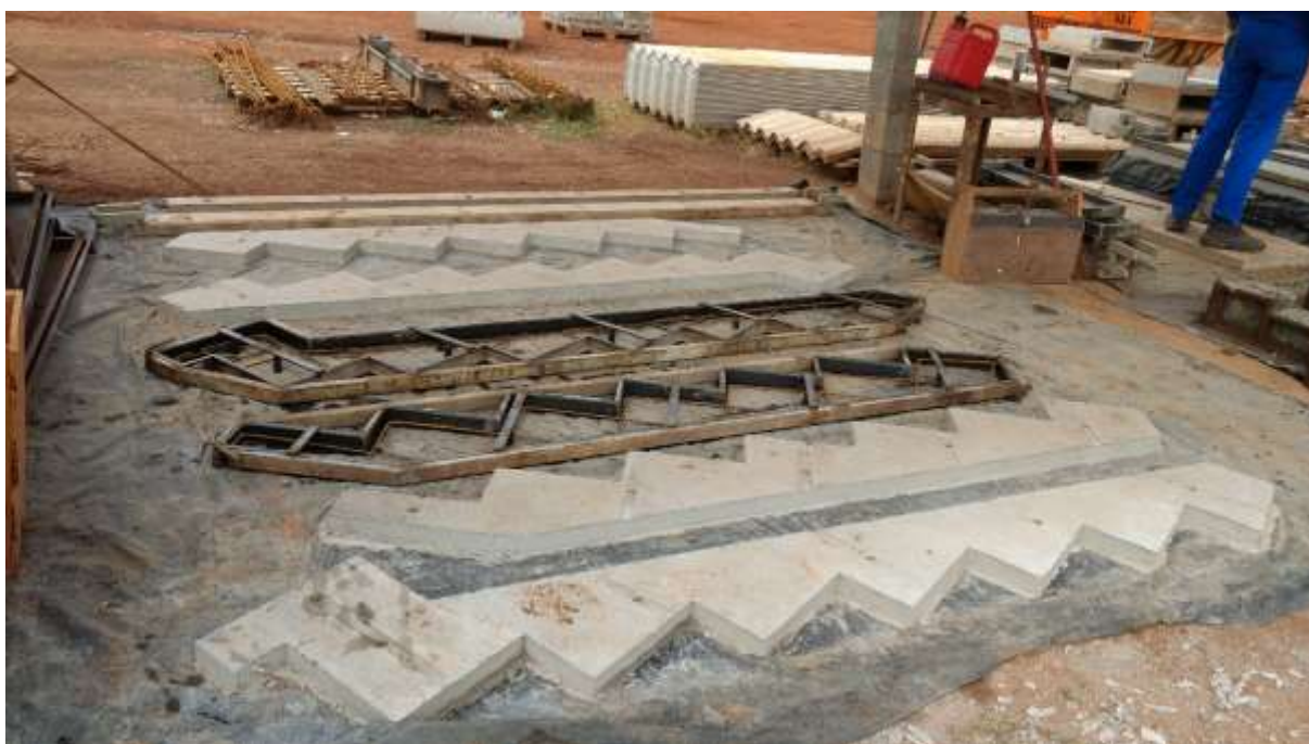
Figura 27: Molde para a construção da viga jacaré
