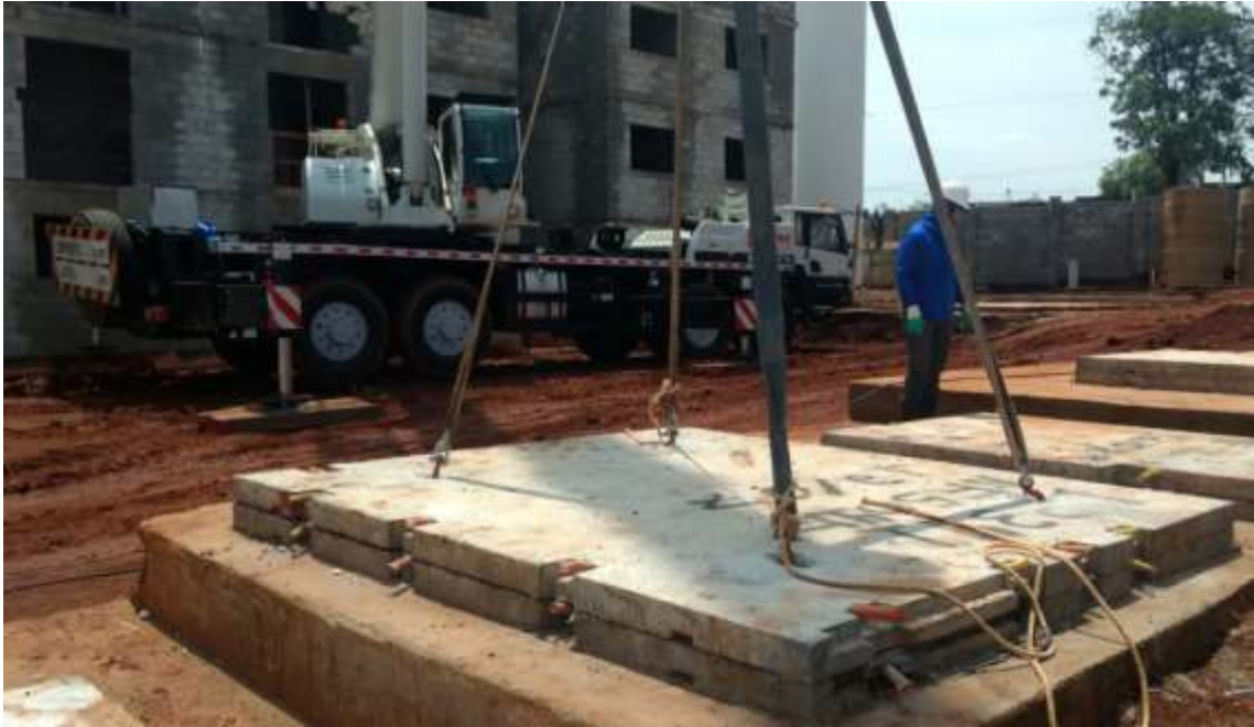
Figura 31: Laje içada por 4 pontos para evitar fissuras.
