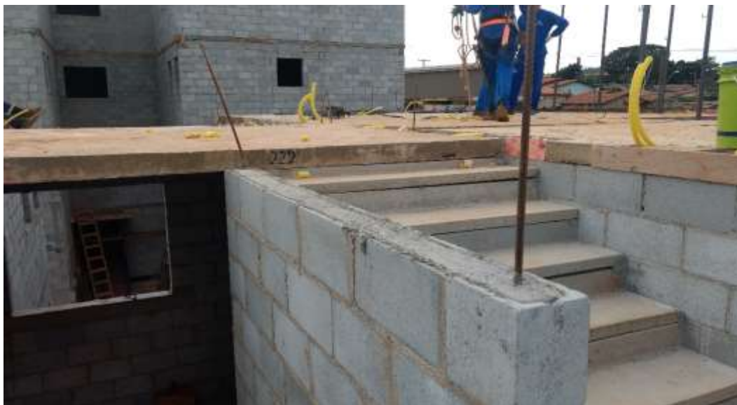
Figura 19: Última fiada de bloco canaleta, grauteada na vertical e horizontal.
