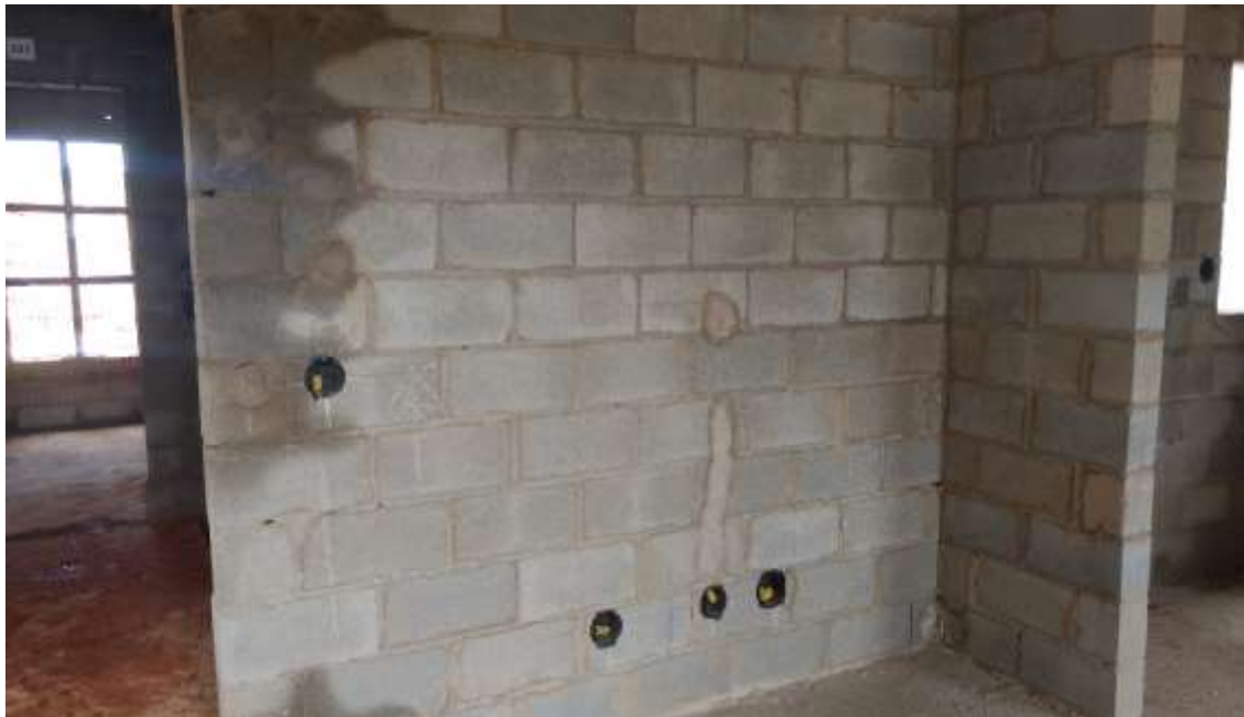
Figura 37: Abertura realizada na sala, para instalação de tomadas e interruptores
