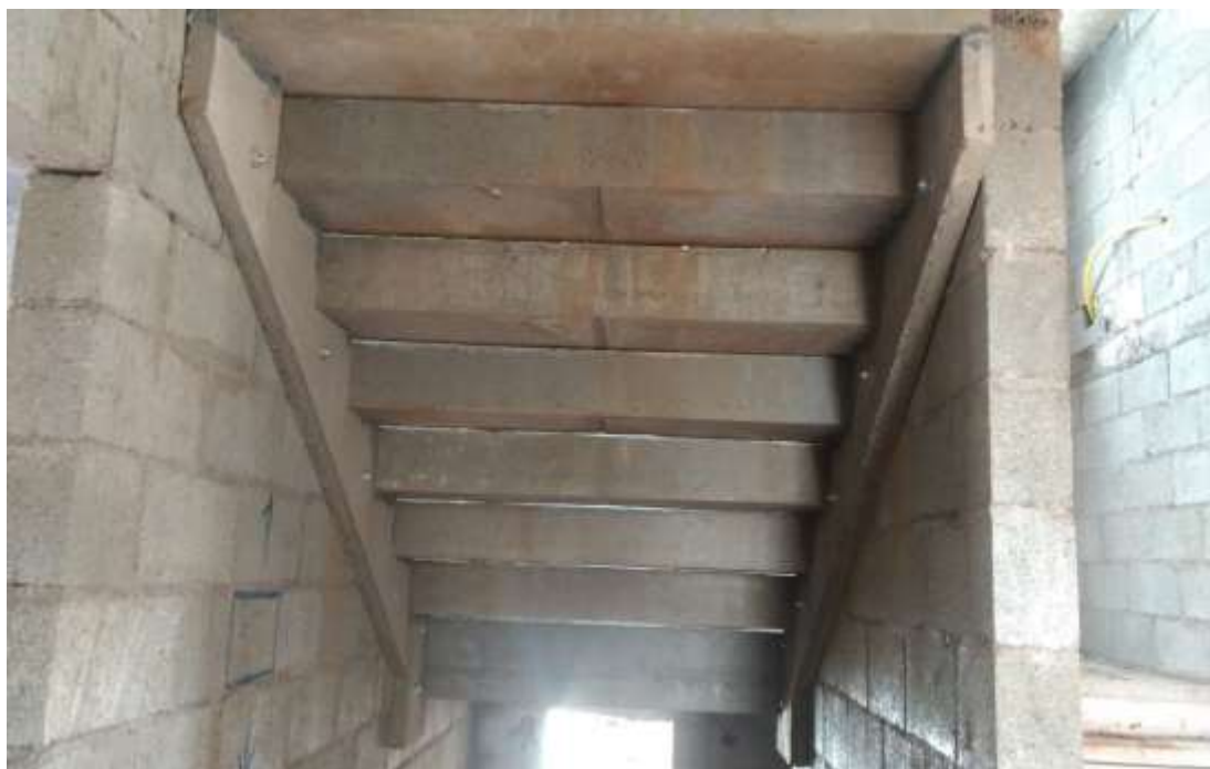
Figura 28: Viga jacaré parafusada na parede
