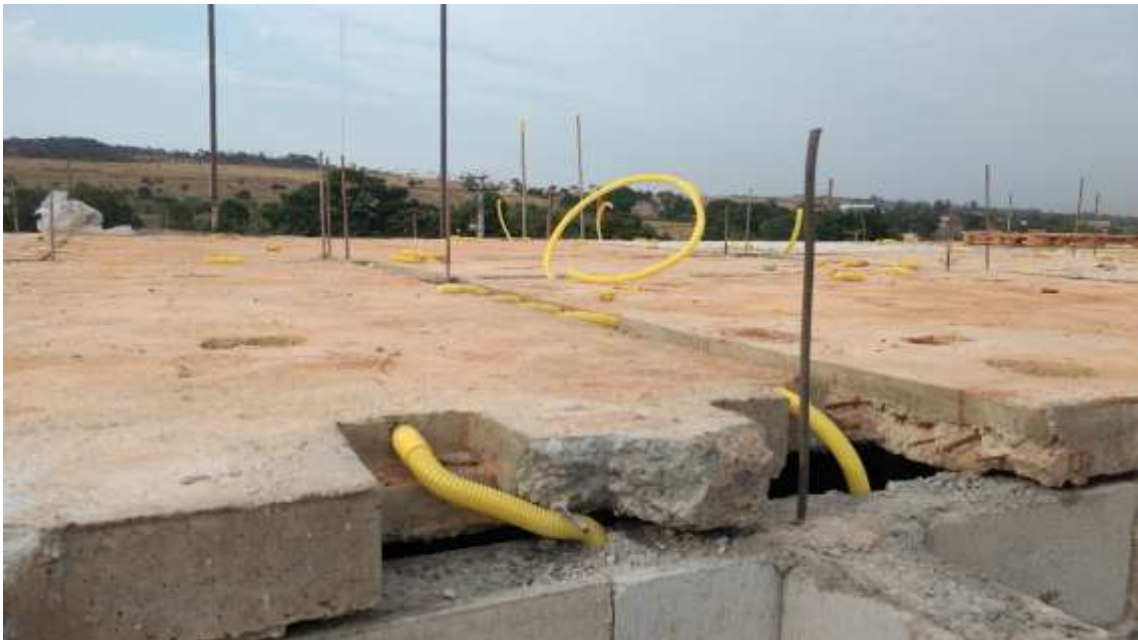
Figura 34: Conectado os eletrodutos da laje com os da alvenaria
