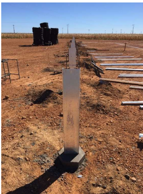
Figura 14: Estrutura metálica mono pé concretada no solo
