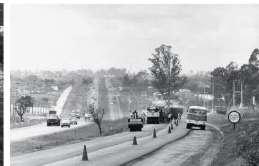
Pavimentação da BR-153. Fonte: O Carreteiro.
