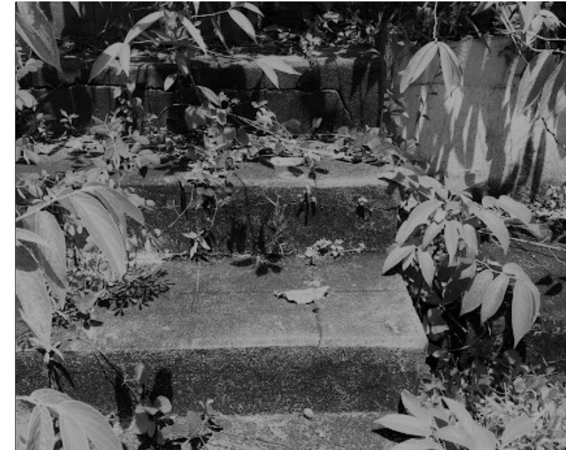
Escadaria de acesso.
