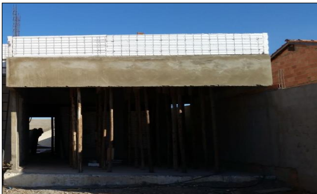
Figura 27 - Escoramento para a execução das lajes
