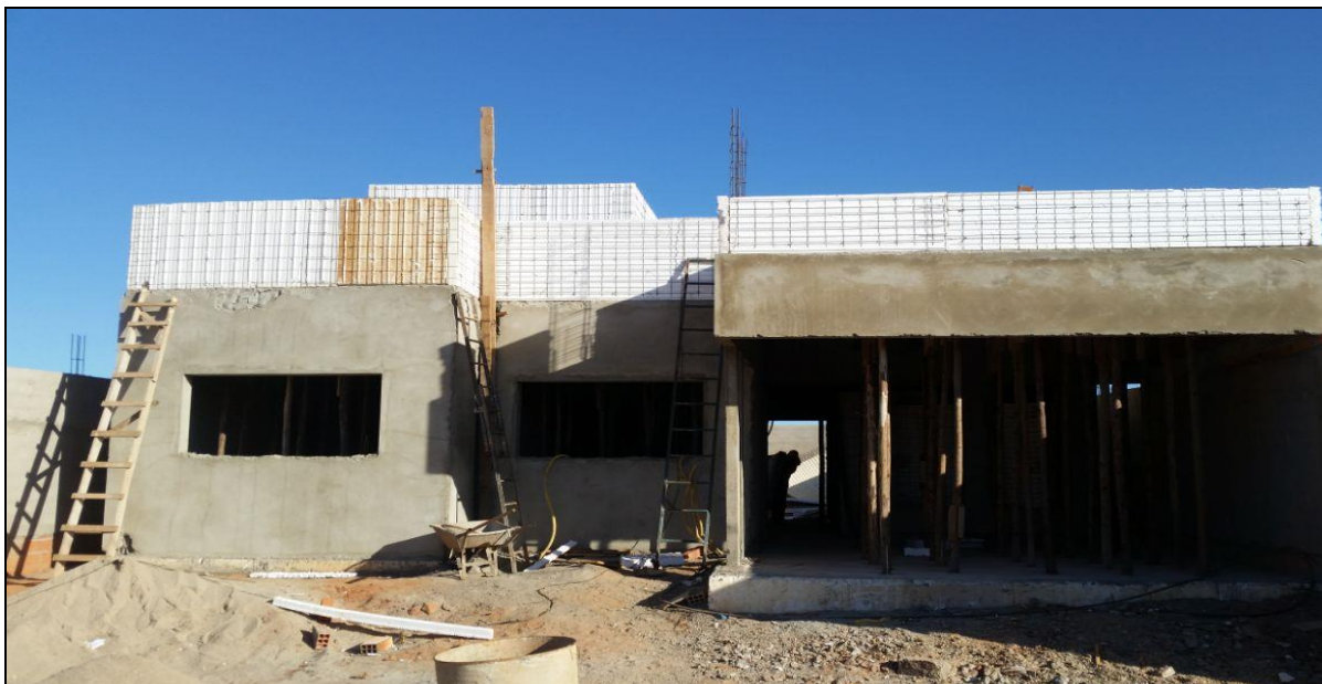
Figura 26 – Aplicação do reboco nas paredes externas.
