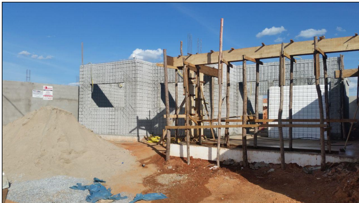
Figura 25 – Aplicação do Chapisco nas paredes externas.
