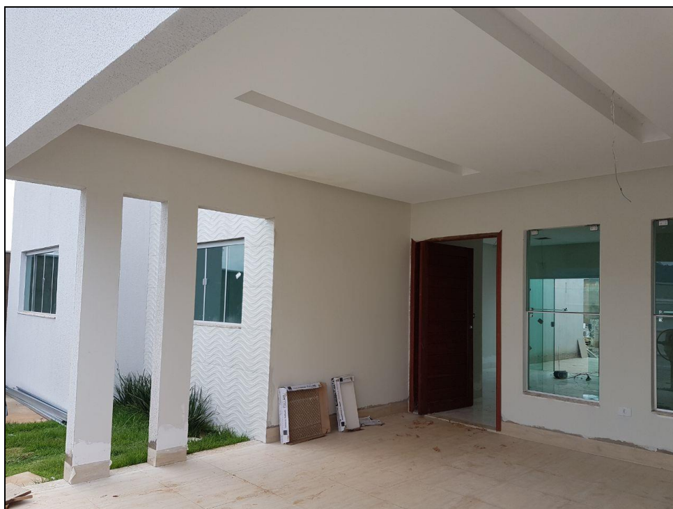
Figura 32 – Instalação de portas e janelas.
