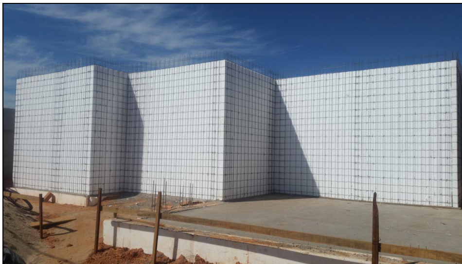
Figura 21 – Paredes afixadas sobre a fundação.
