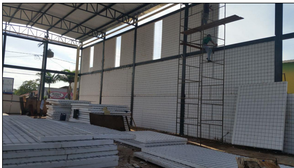
Figura 9 - Paredes de vedação em galpão
