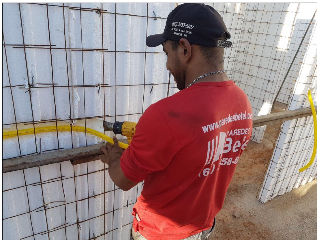
Figura 22 – Abertura de fendas para a passagem de tubulações e sistema elétrico.
