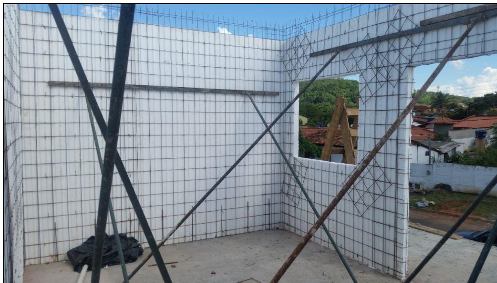
Figura 8 – Escoras para garantir prumo
