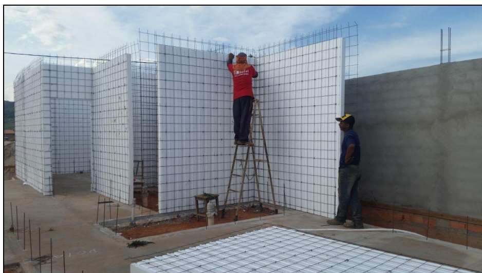
Figura 20 - Encaixe dos painéis sobre a fundação.
