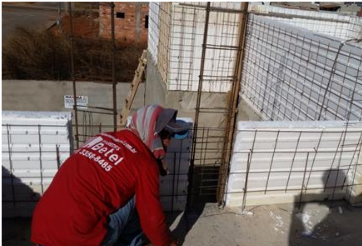
Figura 31 - Paredes para a execução do telhado.
