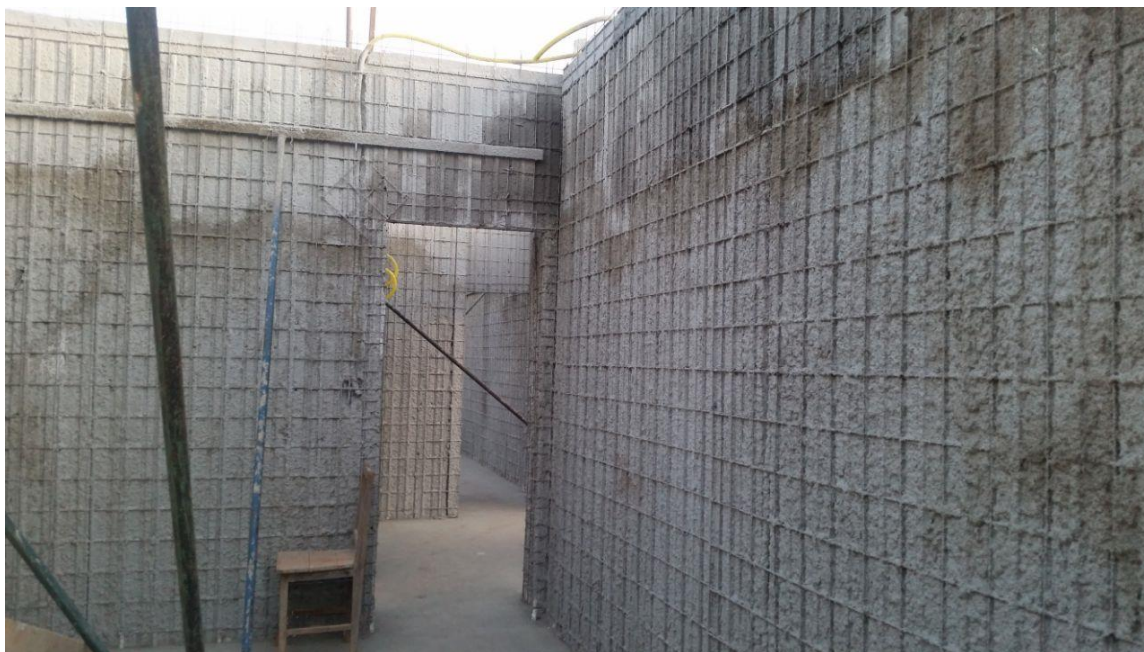
Figura 24 - Aplicação do Chapisco nas paredes internas.
