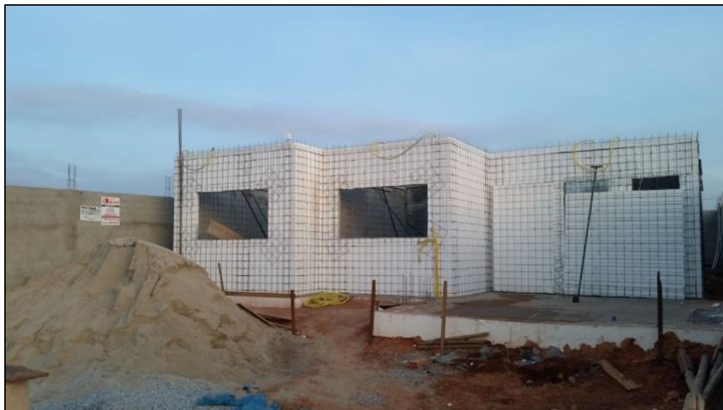
Figura 17 - Casa construída em Goianésia – GO
