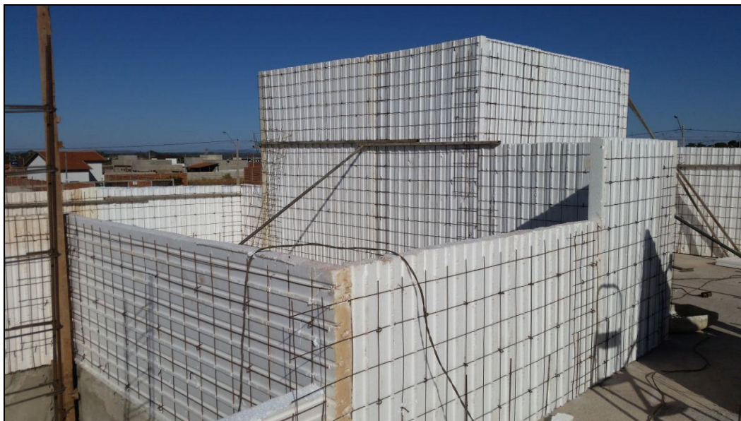
Figura 30 - Posicionamento das paredes sobre a laje.
