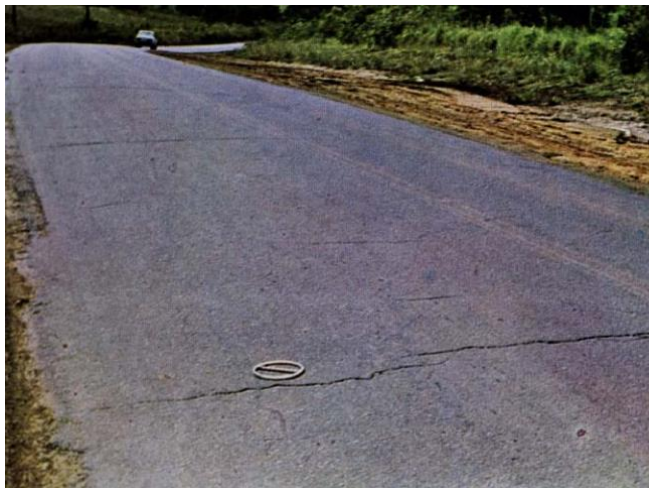
Figura 21 - Trincas transversais
