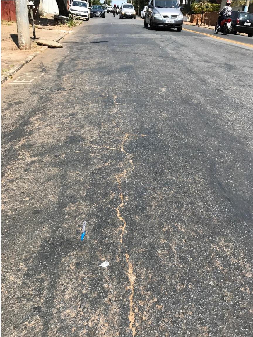
Figura 42 - Trincas longitudinais
