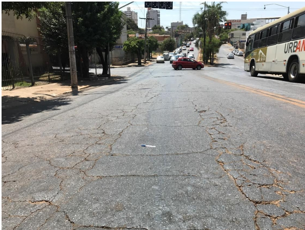
Figura 41 - Trinças em blocos
