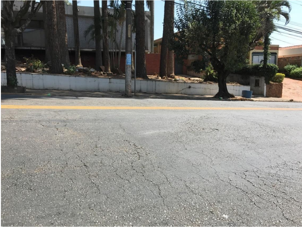
Figura 44 - Trincas transversais
