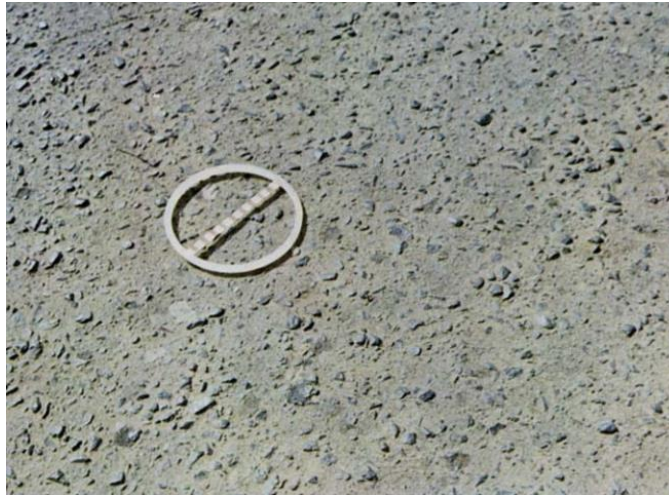
Figura 17 - Desgaste
