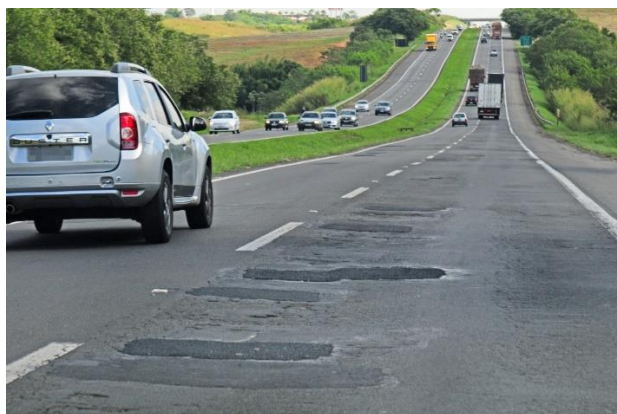
Figura 19 - Remendo
