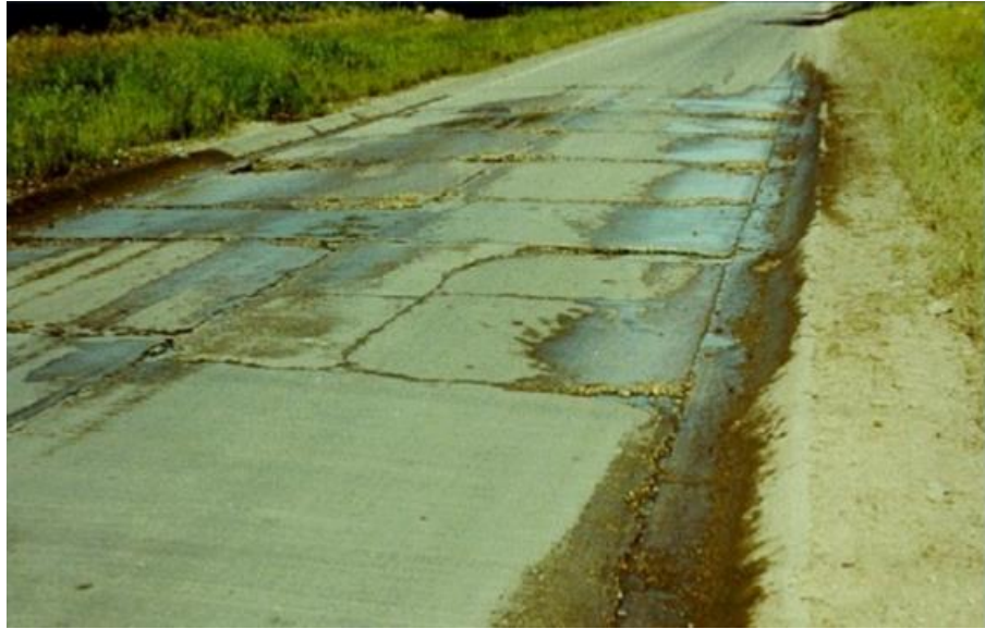
Figura 27 - Bombeamento
