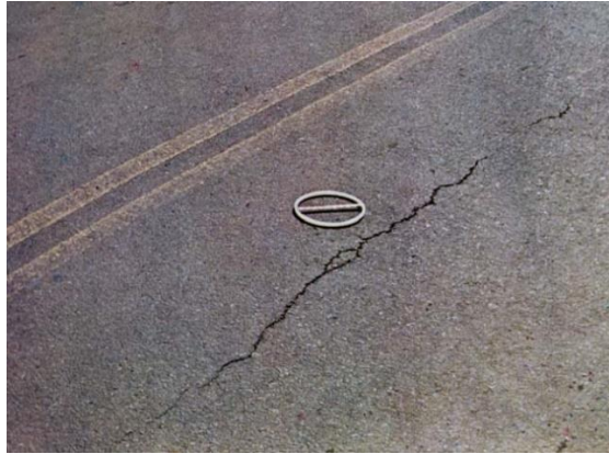
Figura 23 - Trincas longitudinais
