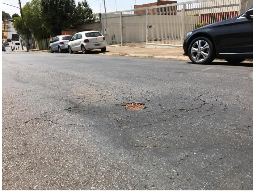
Figura 30 - Deformação permanente
