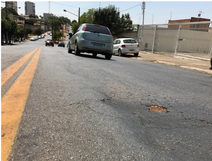
Figura 31 - Deformação permanente
