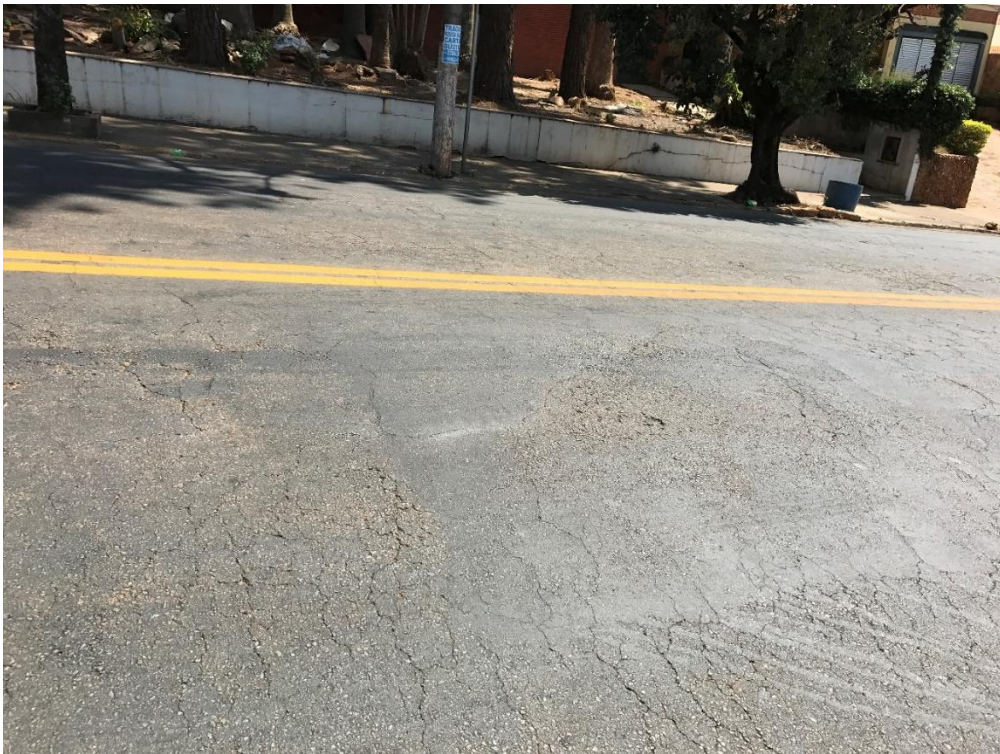
Figura 45 - Trincas transversais
