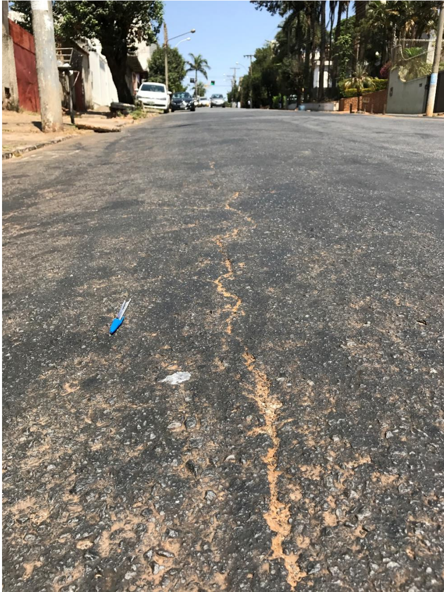
Figura 43 - Trincas longitudinais
