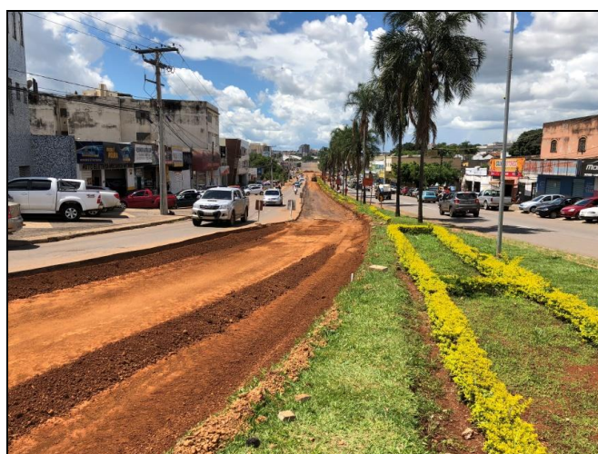
Figura 18: Corte no Trecho da Avenida Brasil.
