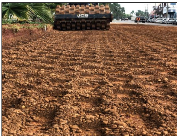
Figura 20: Compatação no Trecho Estudado.
