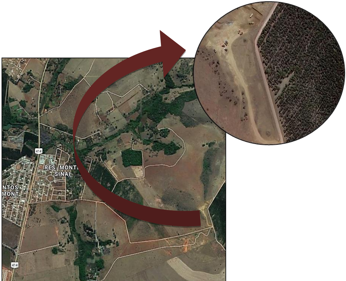
Figura 22: Localização Jazida de Solo Samirão.
