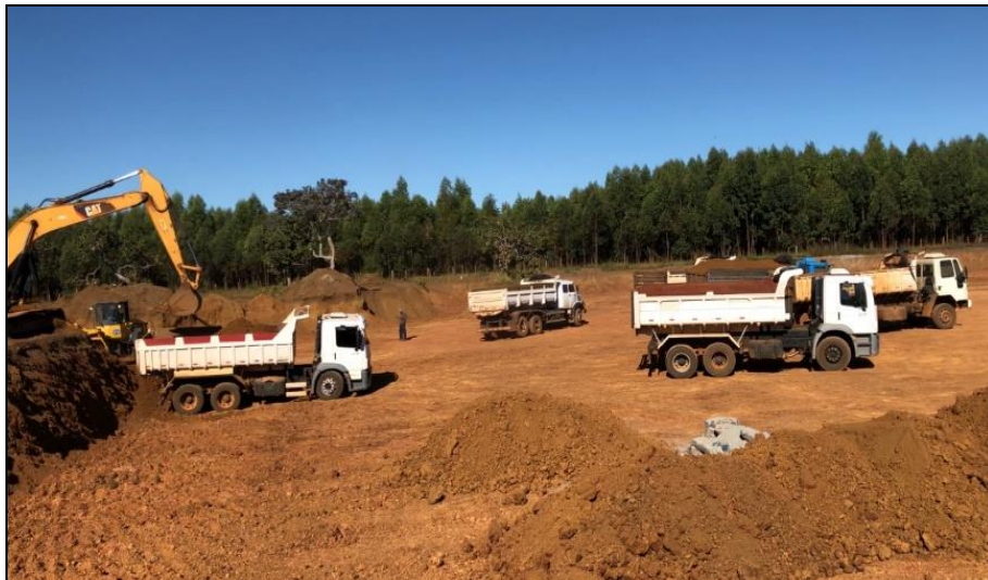
Figura 23: Jazida de Solo Samirão.
