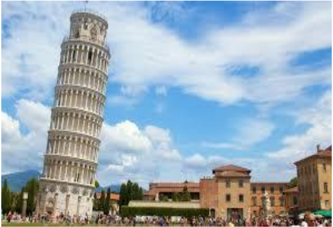
Figura 1-Representação da Torre de Pisa em estado de colapso.
