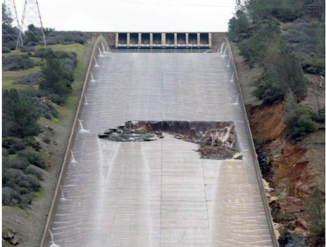
Figura 2-Representação de colapso na barragem de Oroville.
