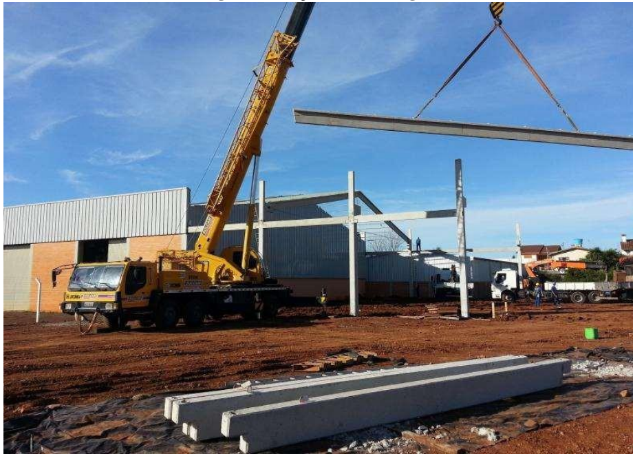
Figura 16 - Içamento da viga
