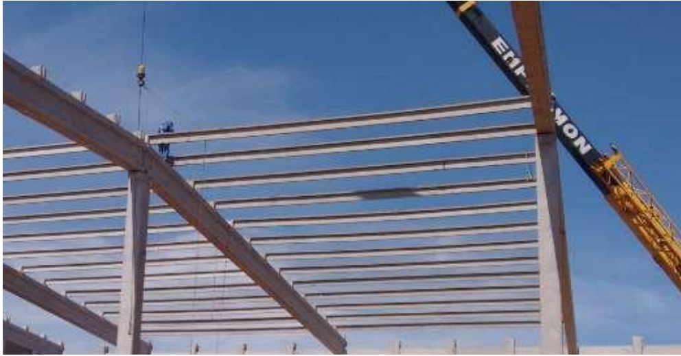
Figura 15 - Cobertura em concreto pré-fabricado
