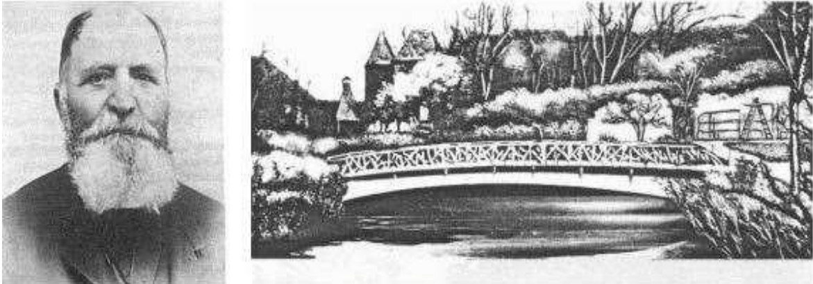
Figura 8 - Joseph Monier e a primeira ponte em concreto armado de sua autoria
