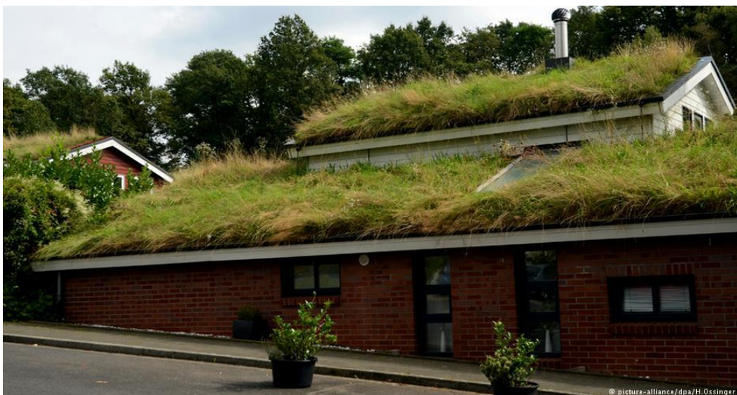
Figura 2 - Telhados verdes em Düsseldorf
