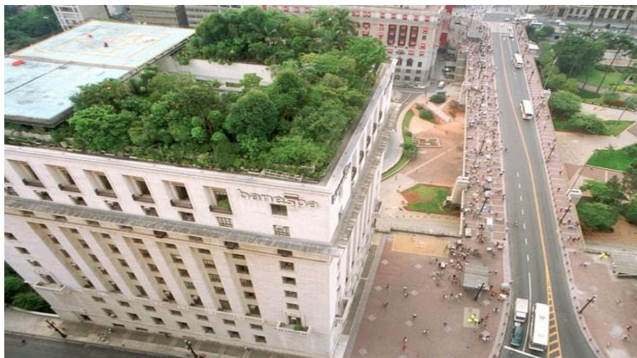
Figura 5 – Sistema Intensivo - Edifício Matarazzo, atual sede da Prefeitura de São Paulo
