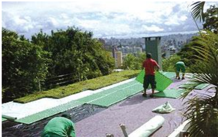
Figura 11 - Membrana alveolar de Polietileno Tereftalado modificado com Glicol
