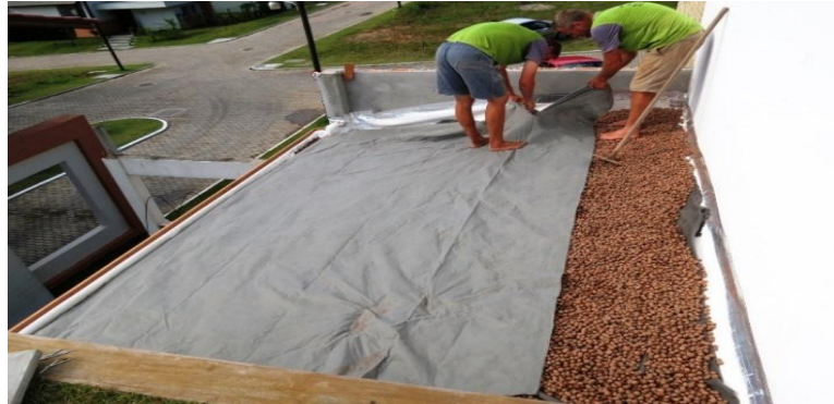
Figura 12- Sistema de drenagem utilizando argila expandida
