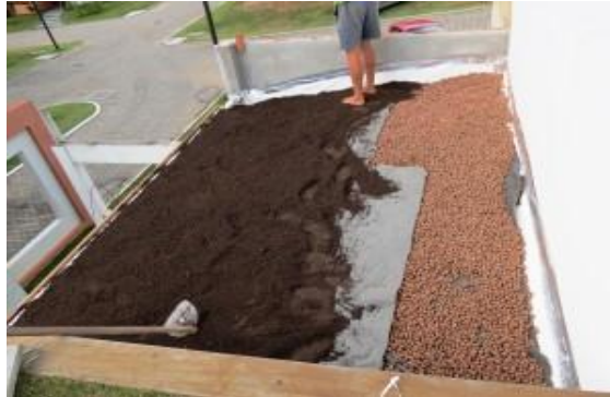
Figura 14 - Aplicação do Substrato
