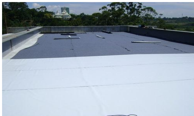
Figura 9 - Aplicação da membrana de PVC
