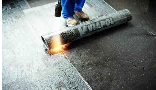
Figura 8 - Aplicação de manta asfáltica
