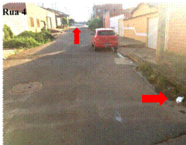
Figura 9 – Lançamento de água de residências diretamente para a rua
