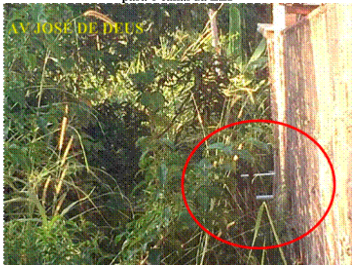
Figura 21 - Fundo de residência com tubulações direcionadas para o canal da ELF
