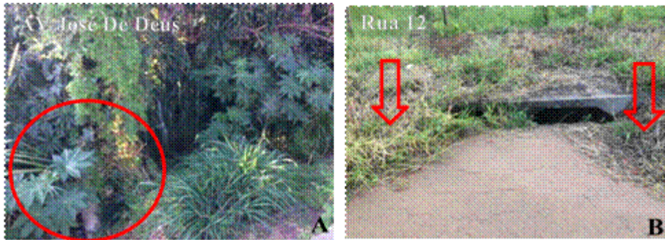
(A) Canal da ELF e Infraestrutura de drenagem urbana
