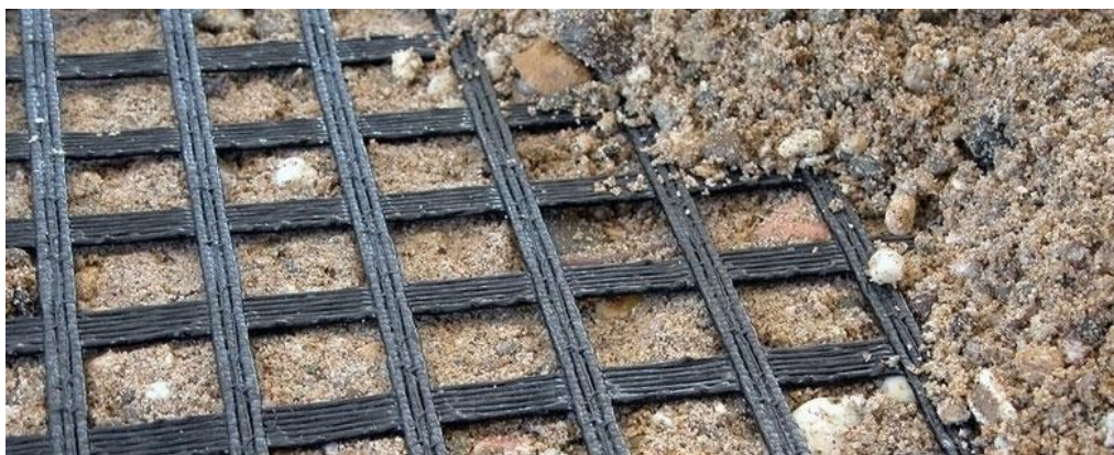
Figura 04 -Aplicabilidade da greogrelha no solo
