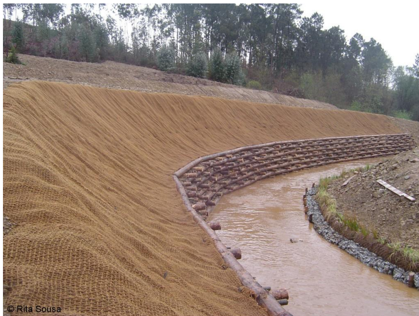
Figura 05 -Geogrelha reforçando contenção em solo mole
