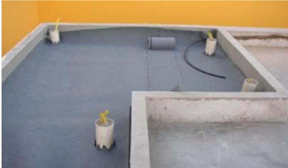
Figura 17 – Geocomposto em laje de concreto
