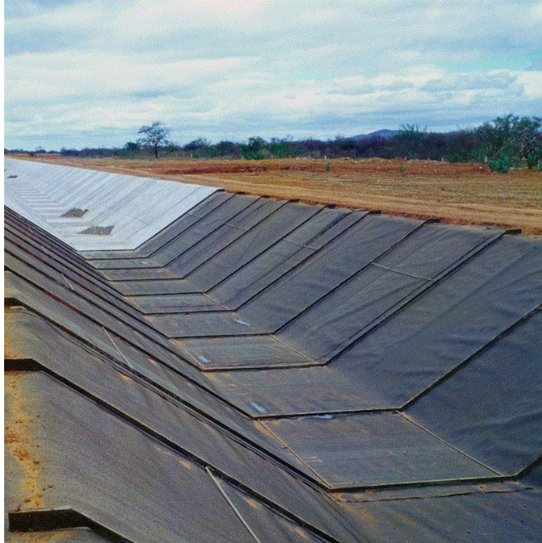
Figura 2 -Aplicação de geomembrana em piscicultura
