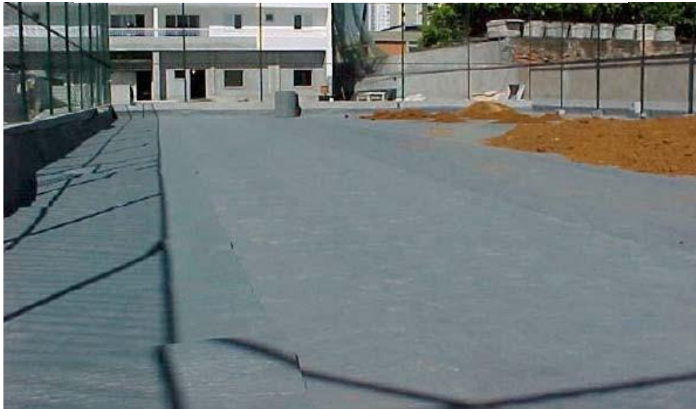
Figura 18 – Sistema de drenagem em campo de futebol
