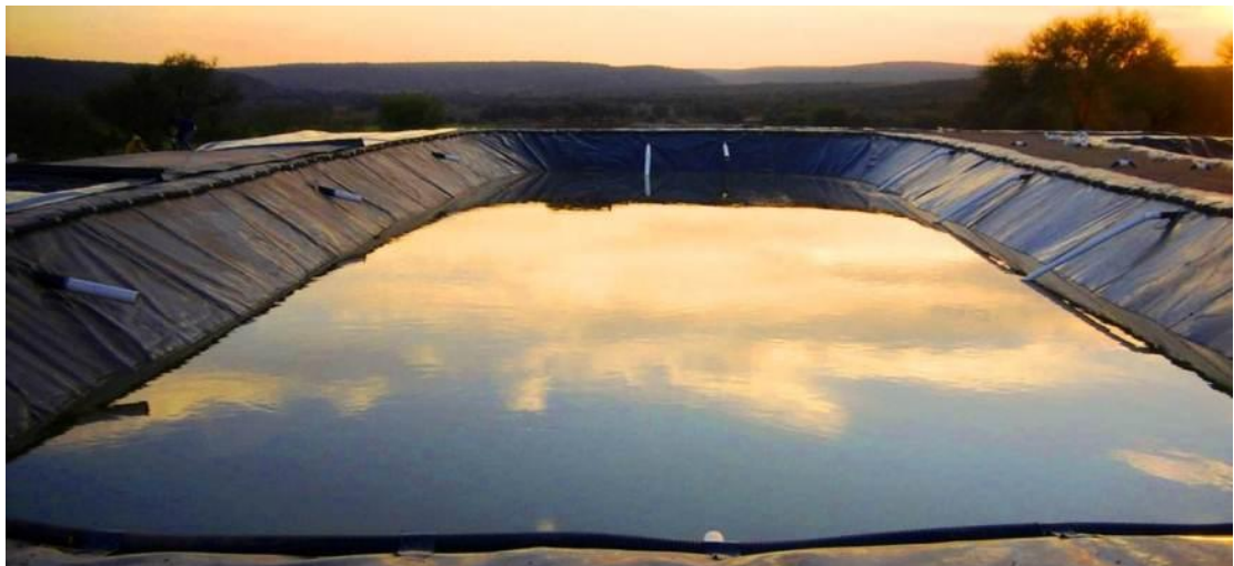
Figura 3 -Geomembrana destinado a recobrimento de lagoa
