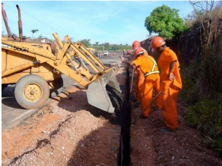
Figura 24 – Abertura da vala drenante
