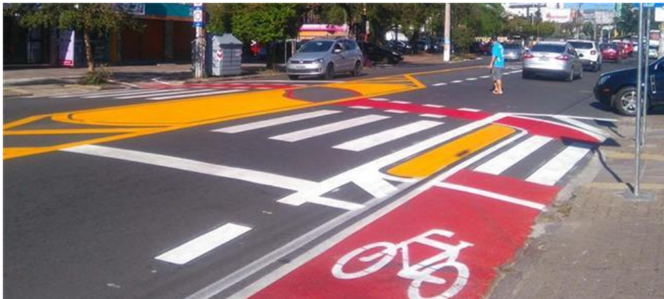
Figura 21 - marcas longitudinais, transversais, de delimitação e inscrições no pavimento
