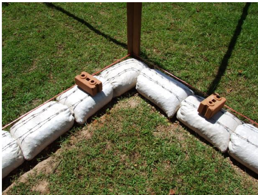
Figura 32 – Conexões entre as fiadas
