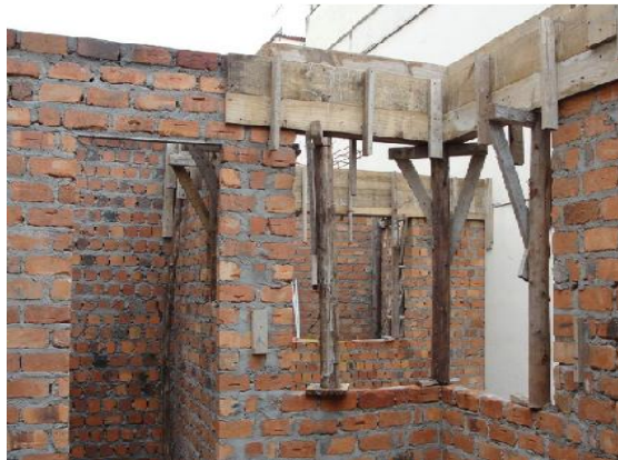
Figura 20 – Alvenaria de vedação com a utilização de blocos cerâmicos.
