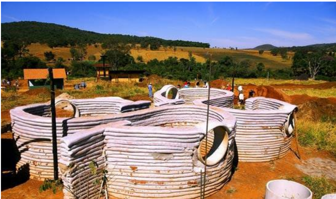
Figura 12 – Edificação em superadobe em Pirenópolis-GO
