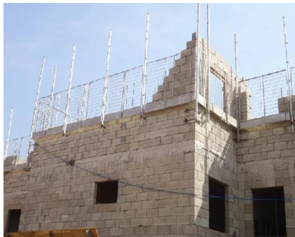
Figura 17 – Alvenaria estrutural com a utilização de blocos de concreto.
