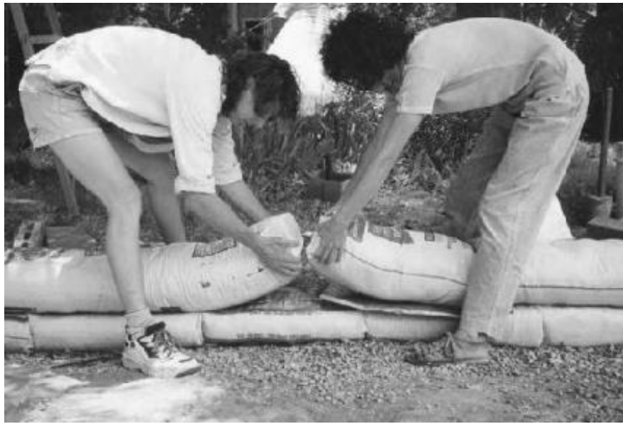
Figura 06 – Posicionamento das embalagens do superadobe.
