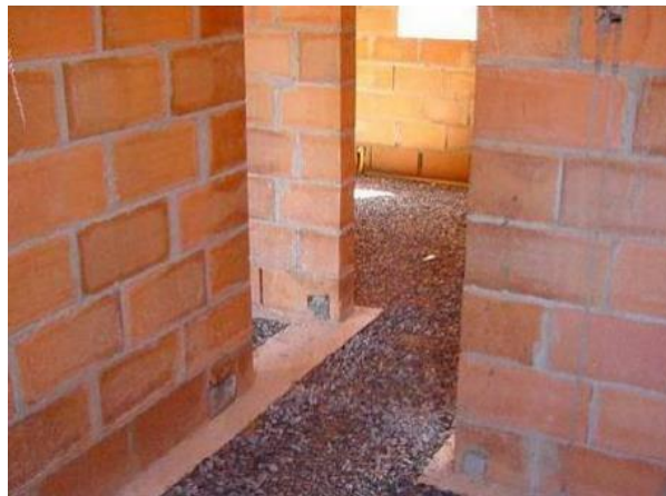
Figura 16 – Alvenaria estrutural com a utilização de blocos cerâmicos.
