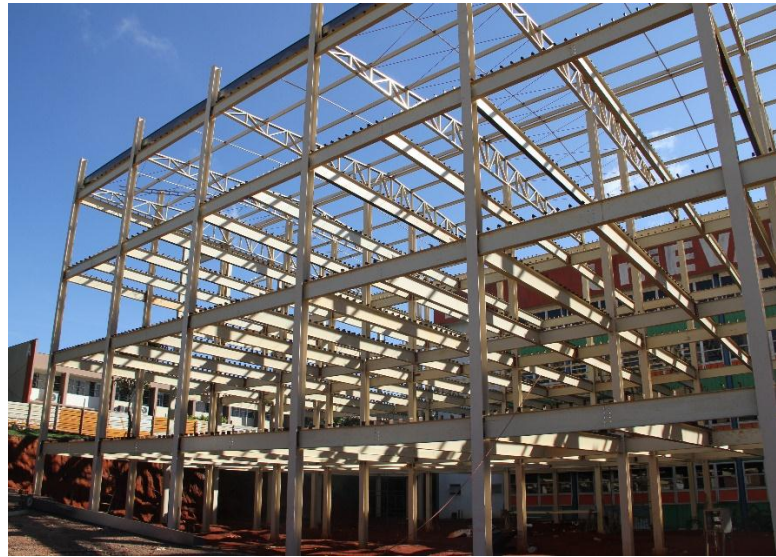
Figura 12 - Estrutura biblioteca UniEvangélica.
