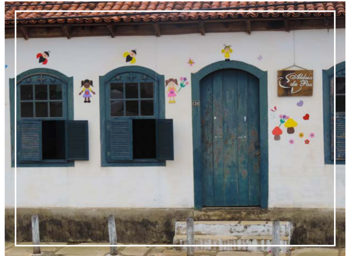
Fachada da edificação
