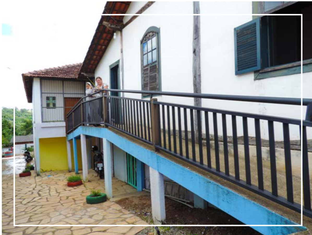
Entrada lateral da edificação
