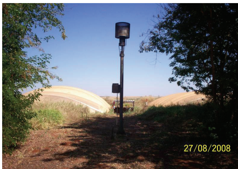
Figura 19 - Queima dos gases emitidos pelos biodigestores Fonte: Produzida pelo autor (2008).
