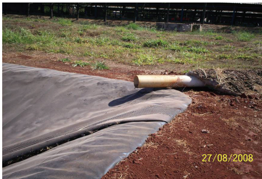
Figura 13 - Dejetos das instalações são transferidos para a lagoa por gravidade Fonte: Produzida pelo autor (2008).
