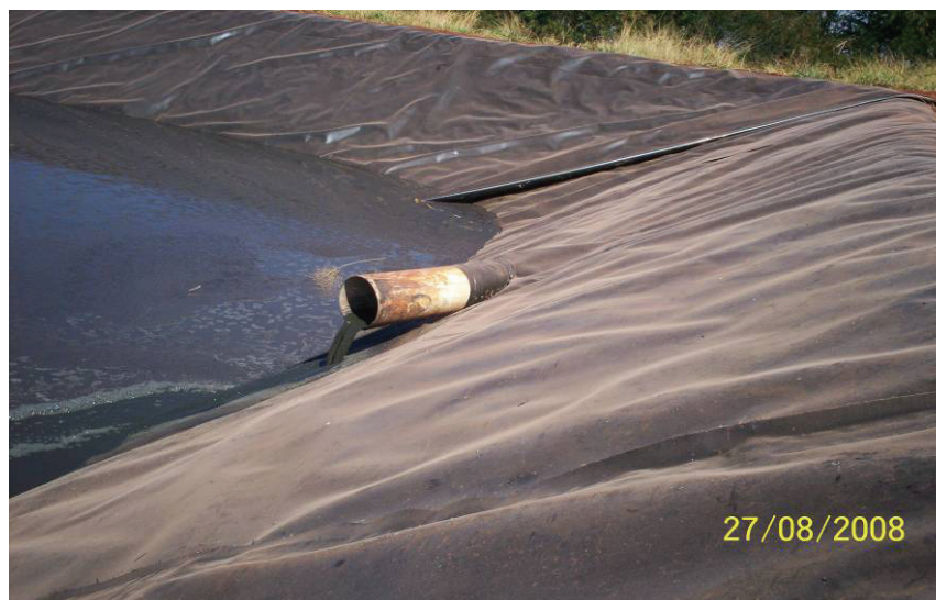
Figura 14 - Dejetos das instalações são transferidos para a lagoa por canos de PVC Fonte: Produzida pelo autor (2008).
