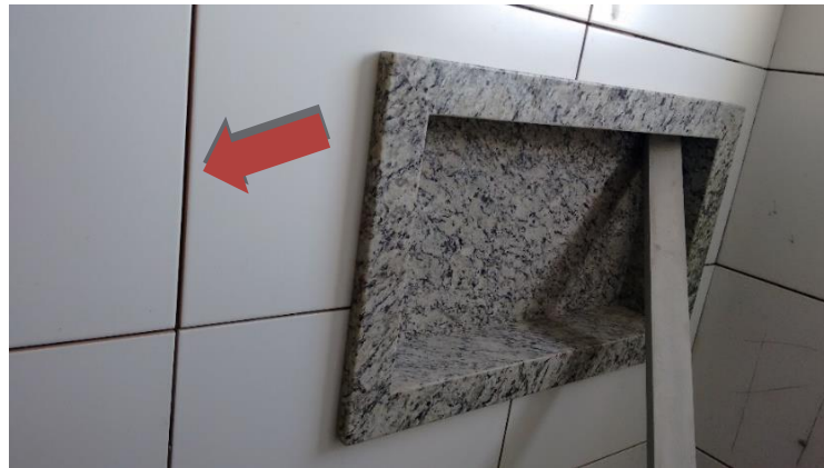
Figura 3 – Exemplificação de juntas de assentamento
