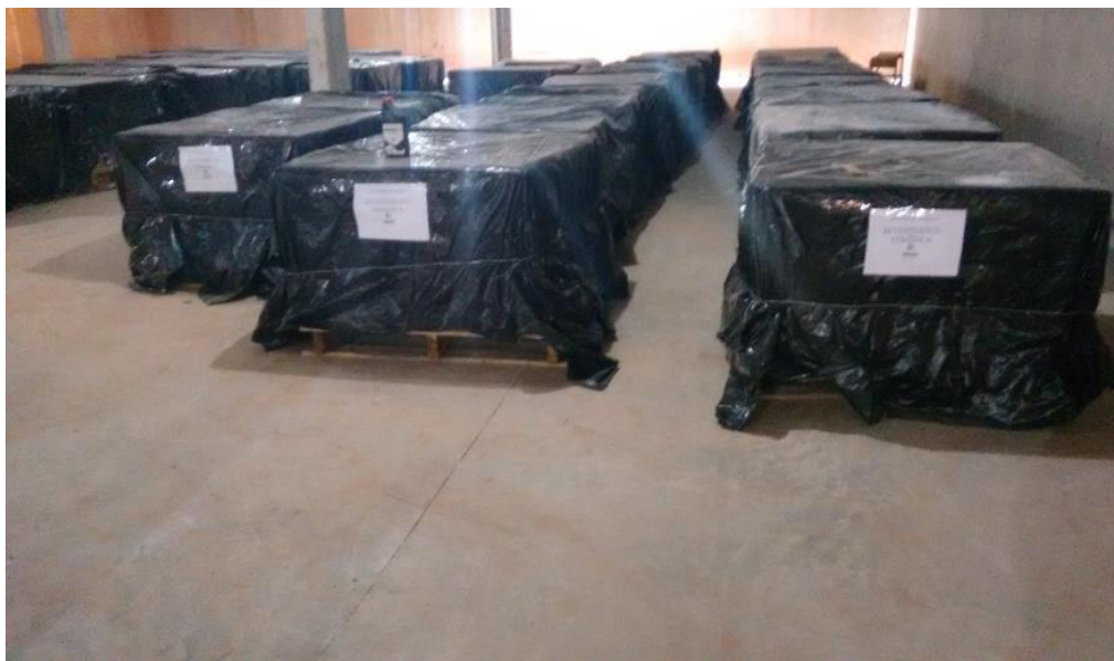
Figura 6 – Armazenamento de revestimento cerâmico
