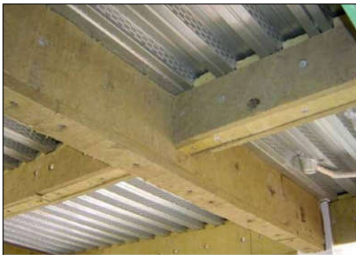
Figura 13 - Aplicação de Placas de Lã de Rocha
