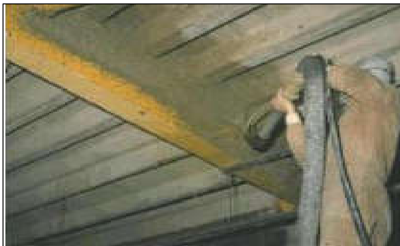
Figura 9 - Aplicação de fibras projetadas em viga de aço
