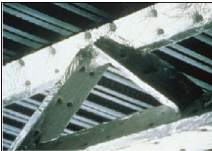
Figura 14 - Aplicação das Mantas cerâmicas
