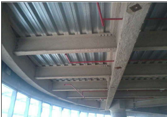
Figura 8 - Argamassa aplicada em vigas de aço
