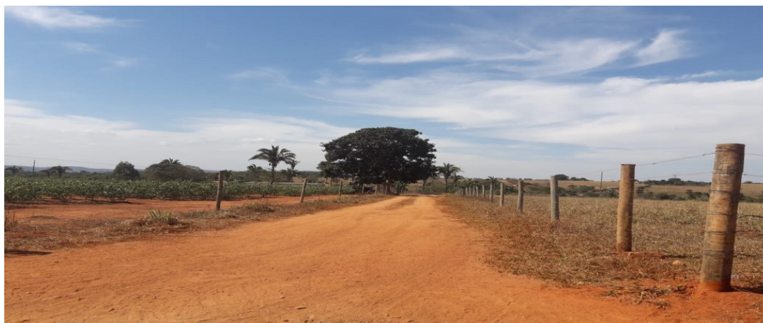
Fotografia 7 – Estrada de terra presente no assentamento.
