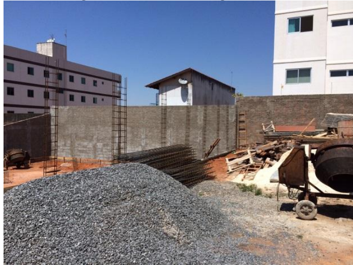
Figura 5 - Local de estocagem da brita
