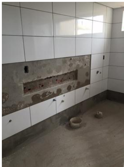
Figura 17 – Revestimento das paredes
