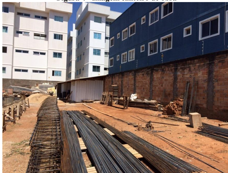
Figura 4 - Imagem canteiro de obra
