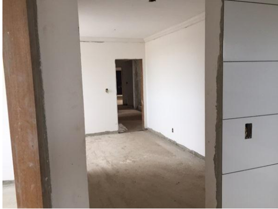
Figura 18 – Paredes emassadas e prontas para recebimento de pintura
