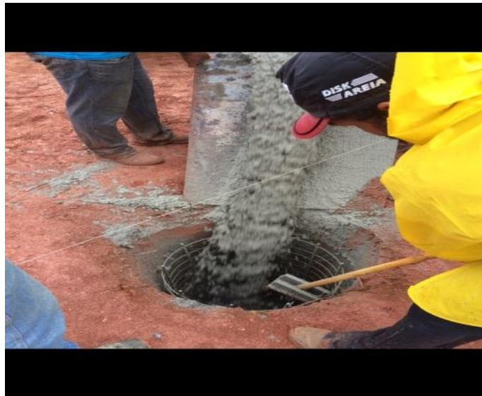
Figura 8 - Momento de concretagem dos tubulões
