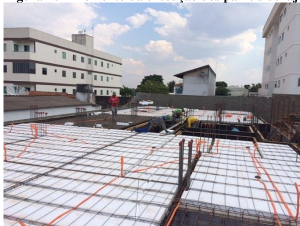
Figura 10 - Momento da execução dos painéis de laje
