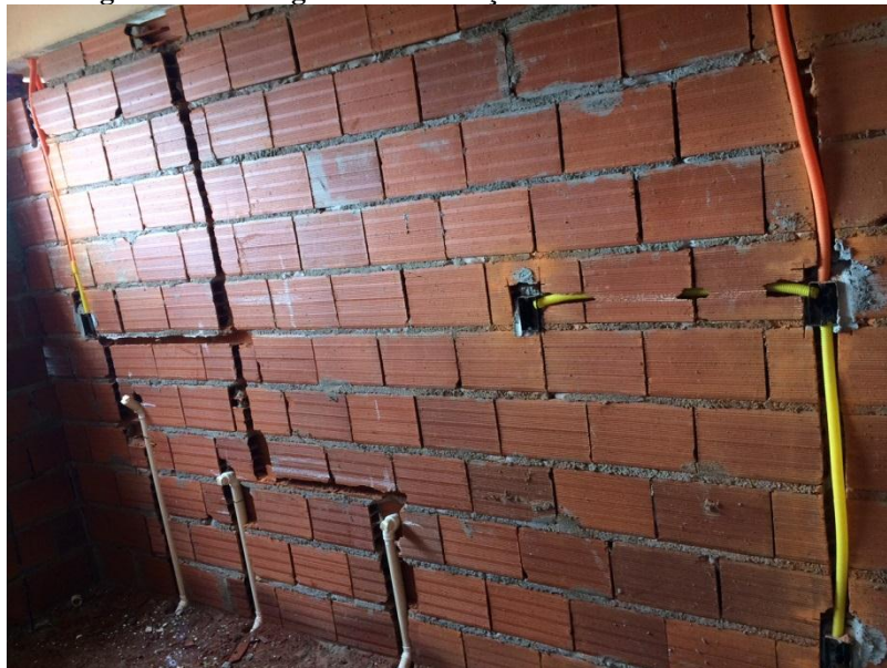
Figura 15 - Passagens das tubulações nas alvenarias
