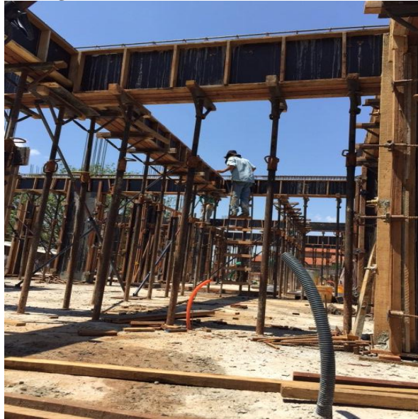
Figura 11 - Sistema de formas da estrutura
