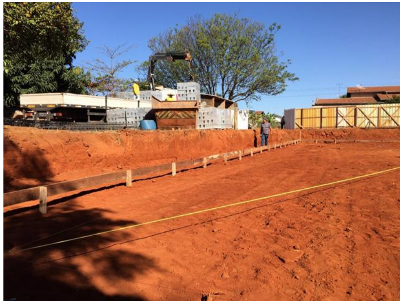
Figura 3 – Execução de terraplanagem
