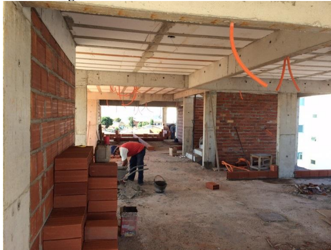
Figura 14 – Painéis de alvenaria
