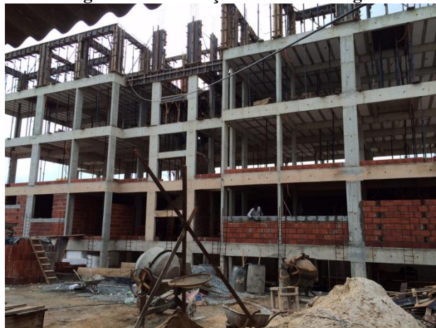
Figura 13 – Execução das contravergas
