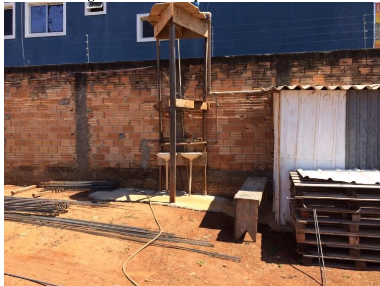
Figura 6 - Banheiro para os funcionários
