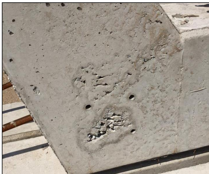
Figura 35 – Brocas no concreto, empresa 2
