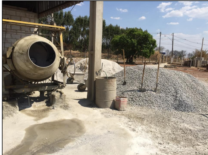
Figura 26 – Fabricação do concreto, empresa 2
