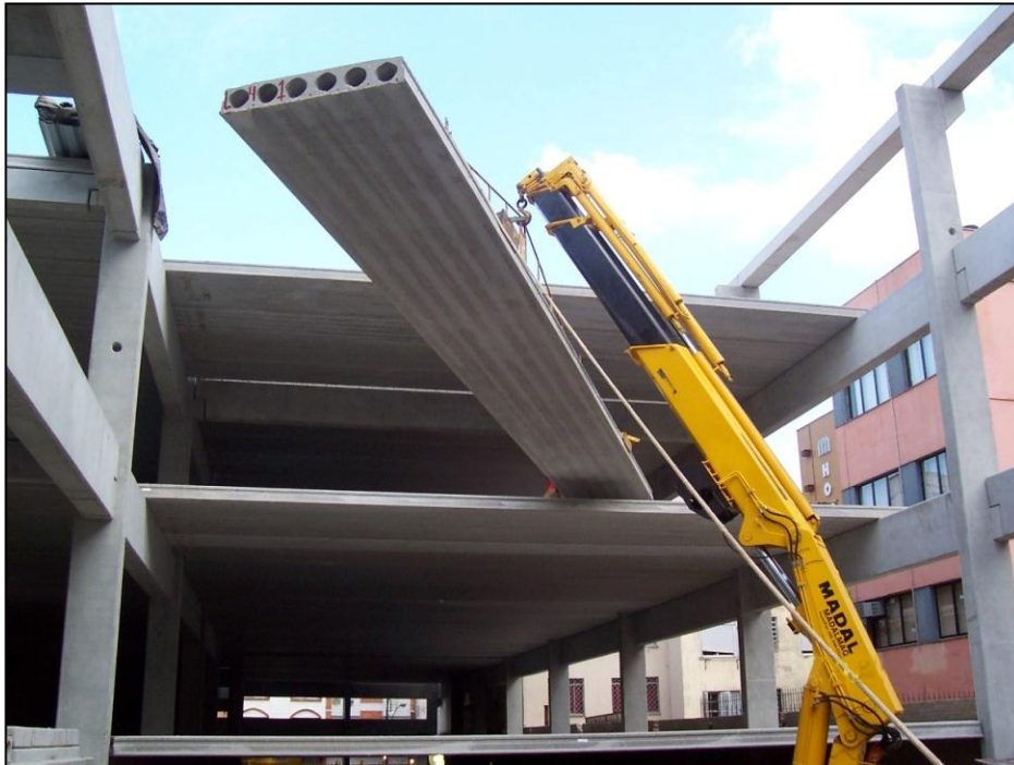
Figura 9 – Estrutura para piso
