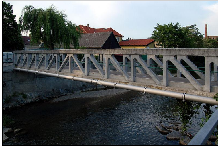
Figura 2 – Vigas treliçadas “Visintini”
