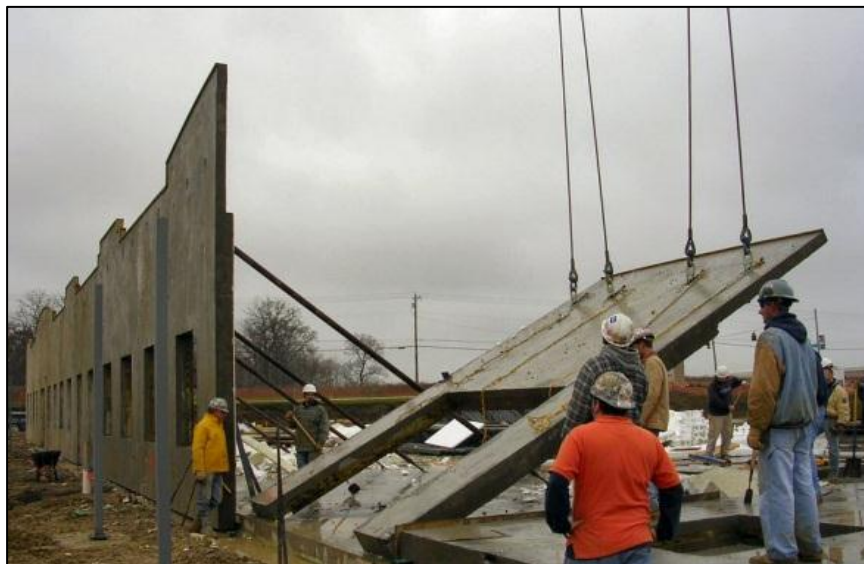
Figura 3 – Aplicações do processo Tilt-up
