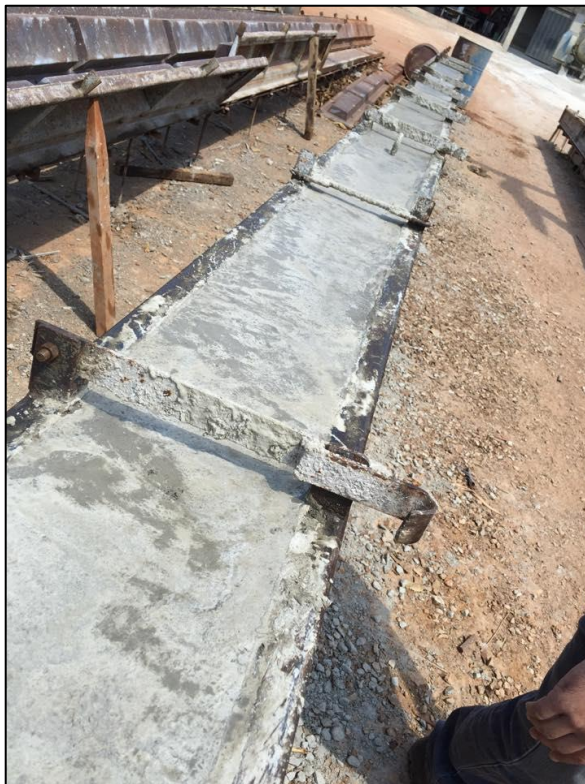
Figura 31 – Peça recém concretada exposta ao sol, empresa 3
