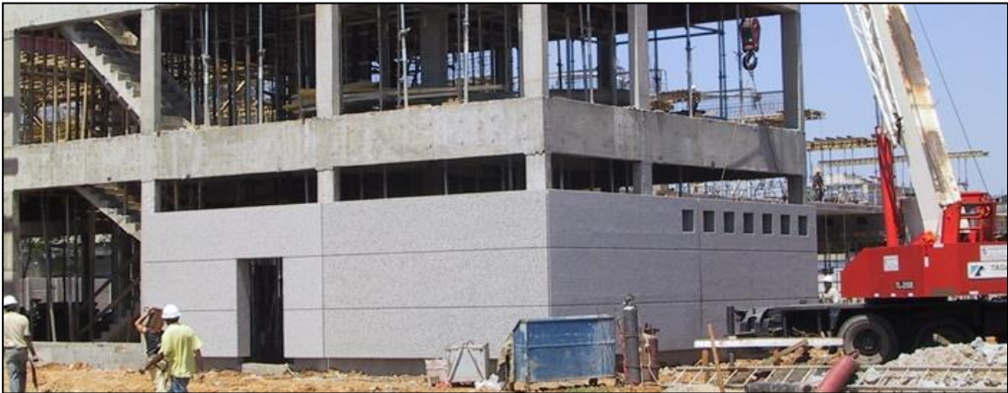
Figura 10 – Sistemas para fachadas
