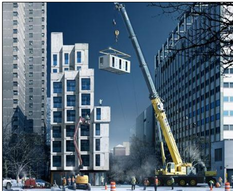
Figura 11 – Construção com sistema celular
