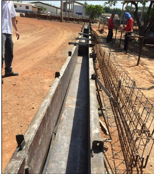
Figura 29 – Estado da fôrma utilizada, empresa 2
