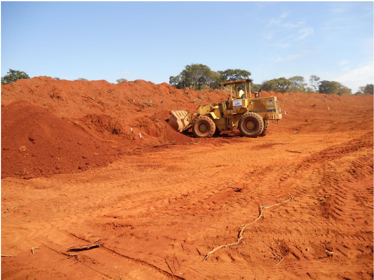
Figura 4 – Jazida de solo de comportamento laterítico
