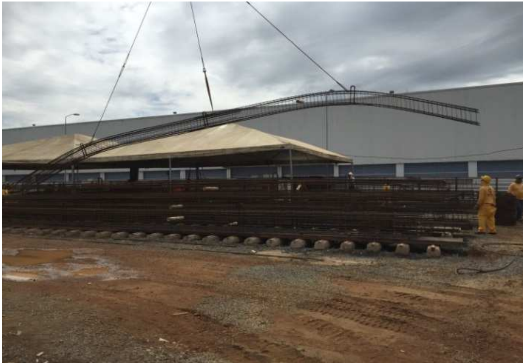
Figura 32-Transporte de armação para pista de concretagem
