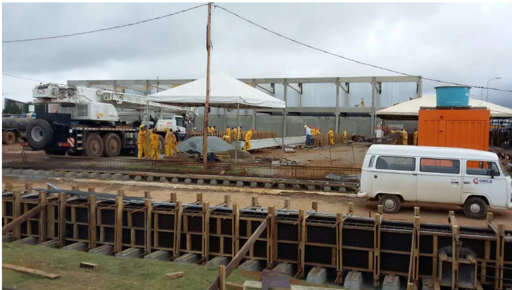
Figura 23-Canteiro de obras, estocagem de armações
