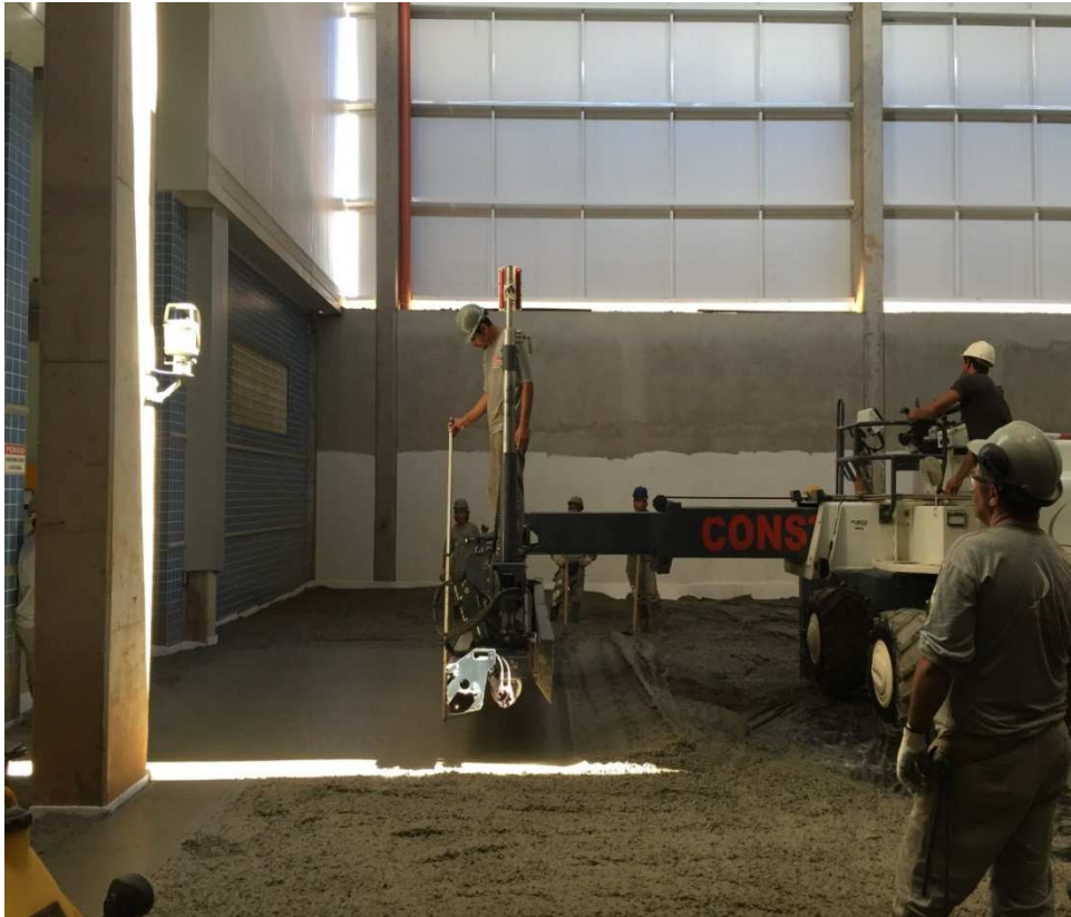
Figura 19-Concretagem do piso, utilização de niveladora a laser
