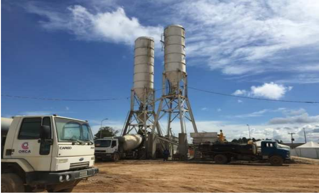
Figura 22-Silos de cimento da usina no canteiro de obra
