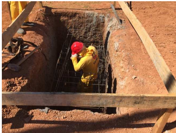
Figura 26-Execução de bloco de concreto
