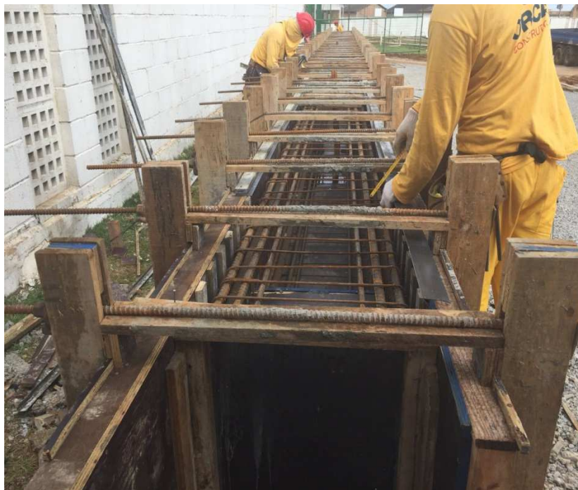
Figura 35-Montagem de fôrmas de pilar
