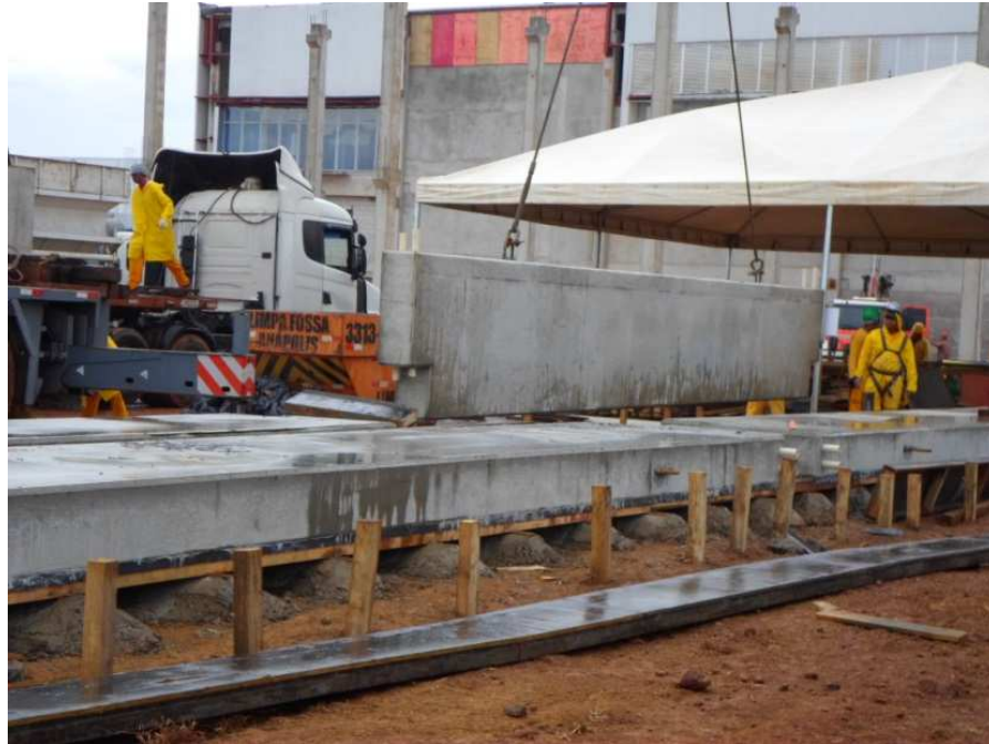
Figura 39-Transporte da peça através de ligação entre laço chumbado e guindaste
