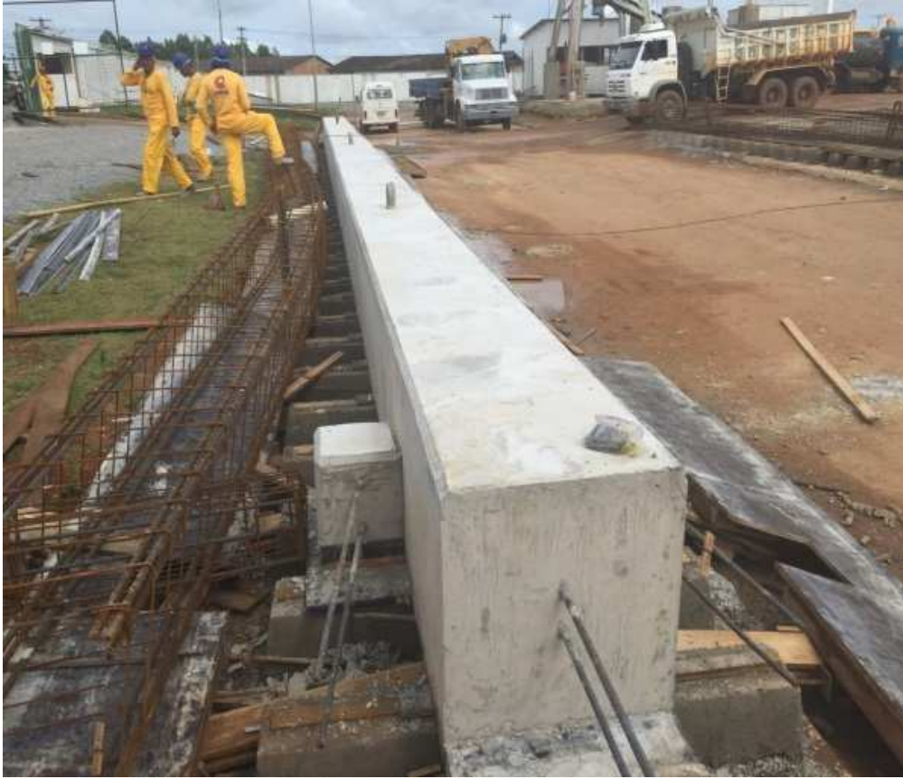
Figura 43-Pilares concretados com consolos e pinos
