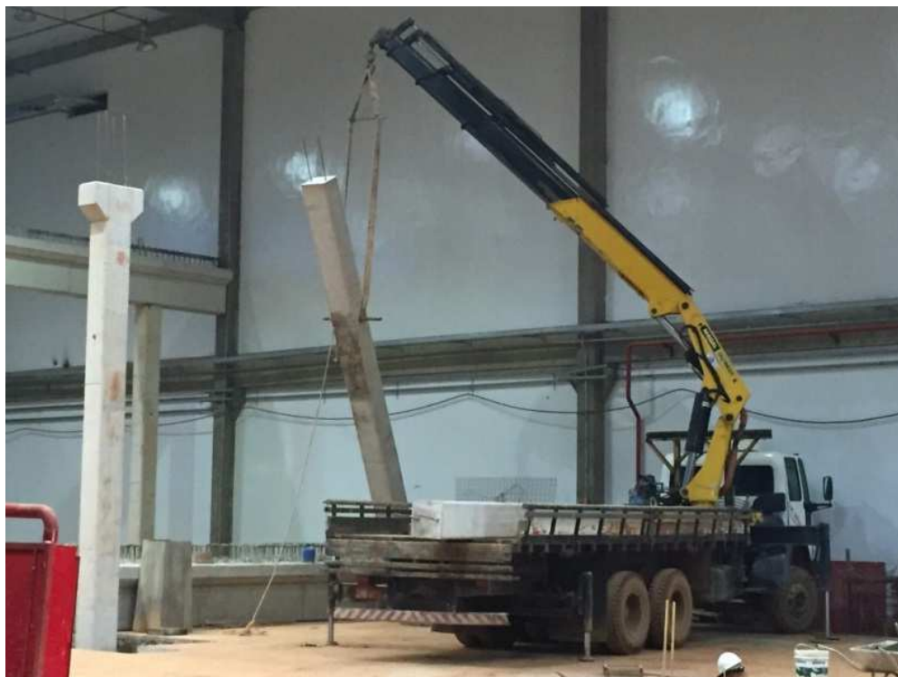
Figura 33-Transporte e montagem de pilar
