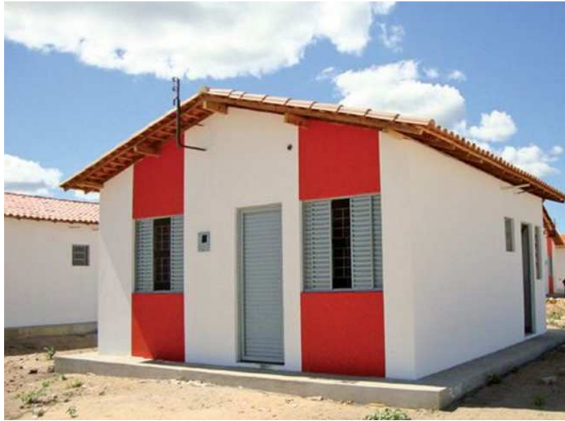
Figura 9-Residência com sistema de parede integral
