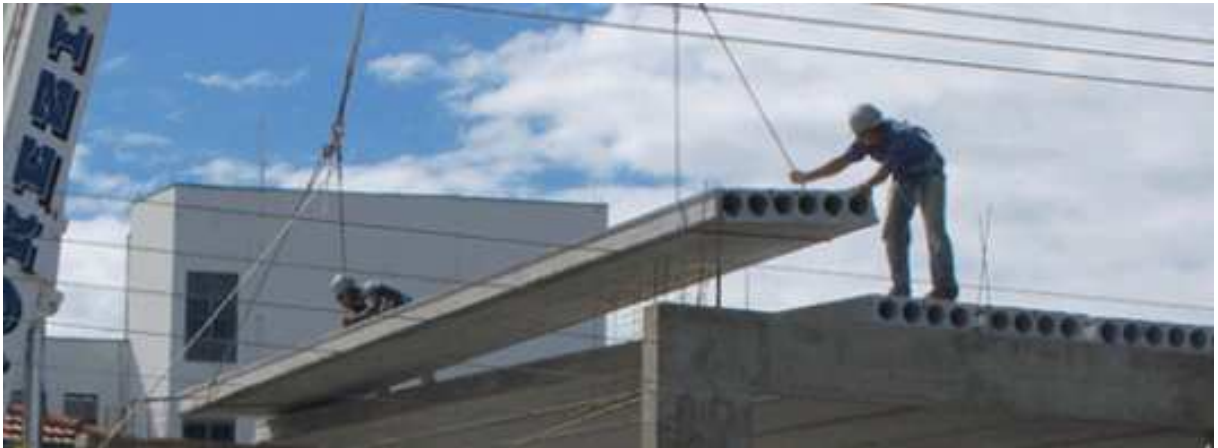
Figura 10-Painéis alveolares protendidos
