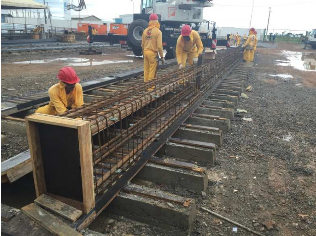
Figura 34-Montagem de fôrmas de pilar
