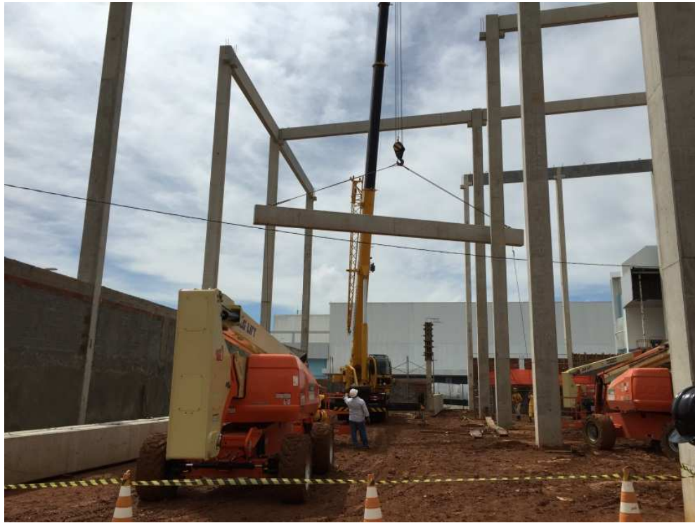
Figura 45-Montagem de vigas intermediárias
