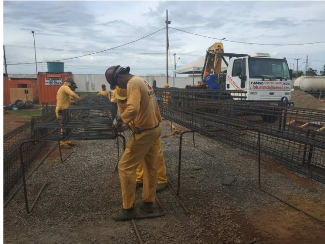
Figura 29-Amarração de vigas e pilares
