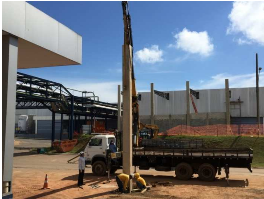
Figura 42-Montagem de pilar e encaixe em cálice de bloco de concreto
