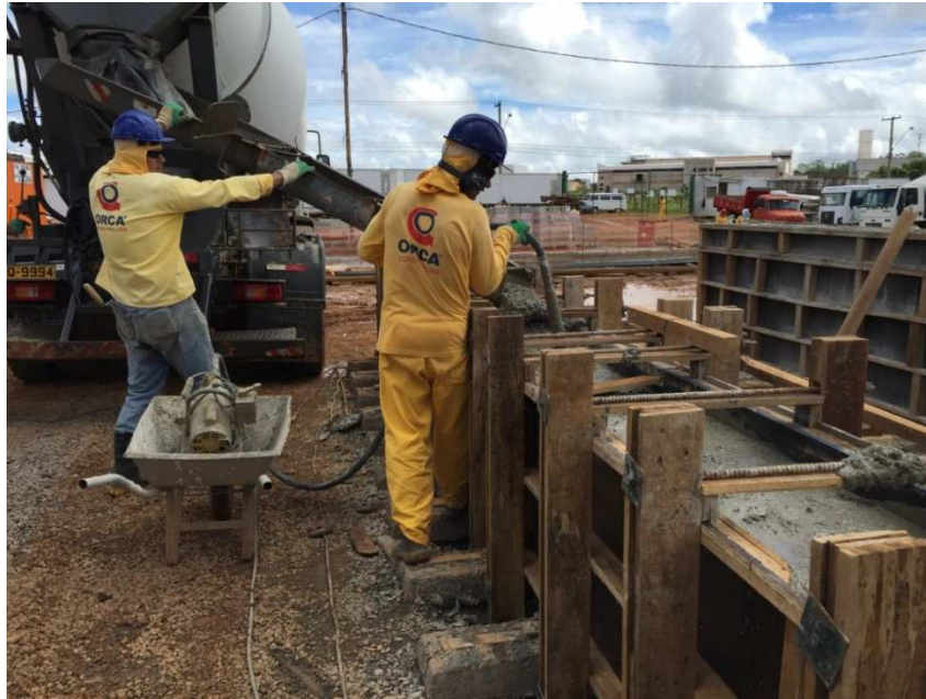
Figura 37-Concretagem de peças com utilização do caminhão betoneira e vibrador
