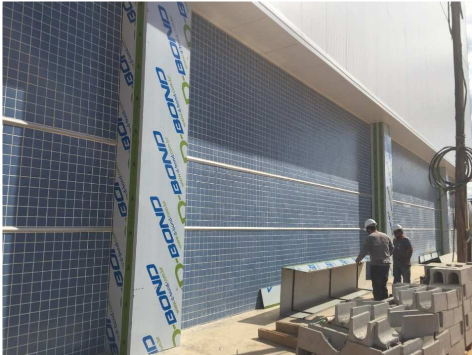
Figura 49-Revestimento em ACM em pilares e Tubulações
