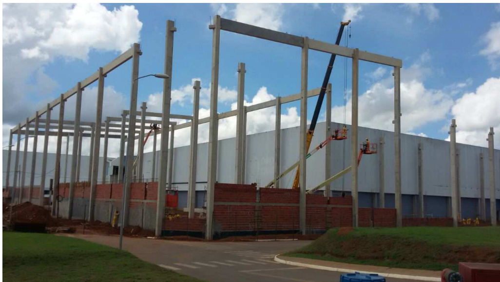
Figura 46-Estrutura com vigas pré-moldas intermediárias montada
