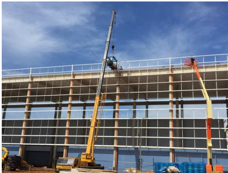
Figura 51-Estrutura em pré-moldado e estrutura metálica
