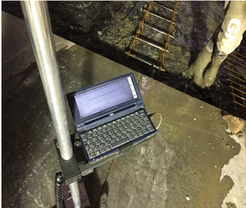
Figura 21-Gráfico de medição de piso, captados pelo processo F-Numbers
