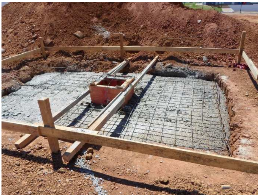
Figura 41-Execução de formas de cálice em bloco de concreto
