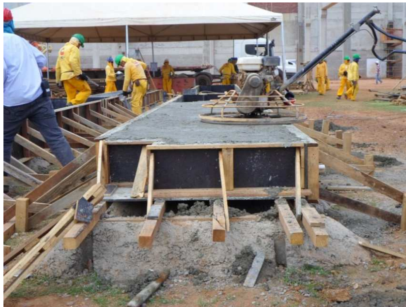
Figura 38-Acabamento em peças feito por meio de lixadeira
