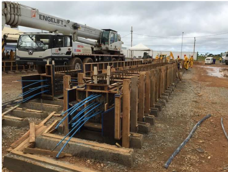
Figura 36-Montagem de fôrmas
