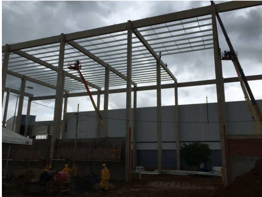
Figura 47-Estrutura em elementos pré-moldados
