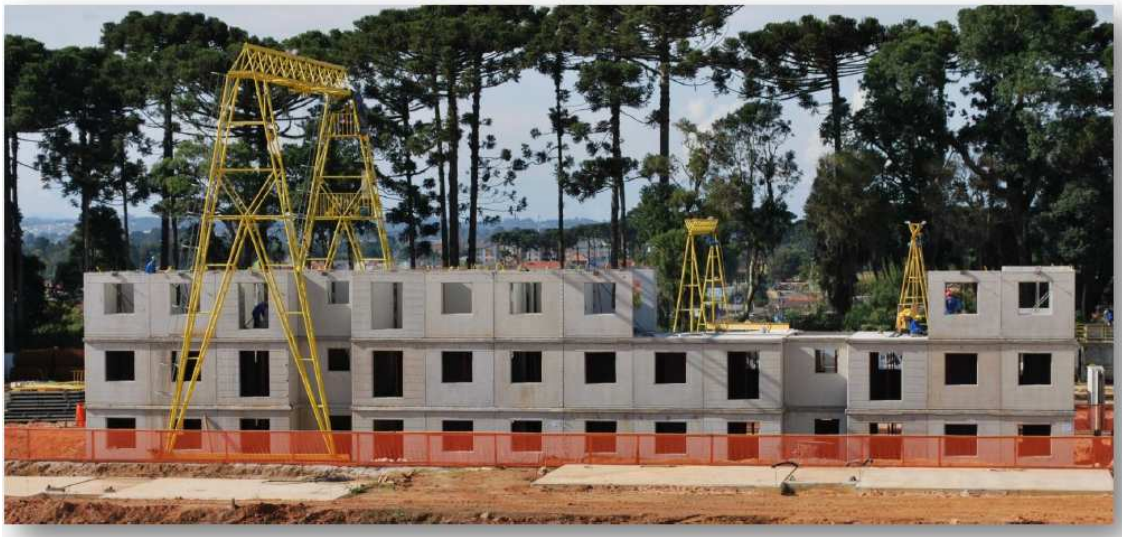
Figura 8-Edifício de painéis estruturais
