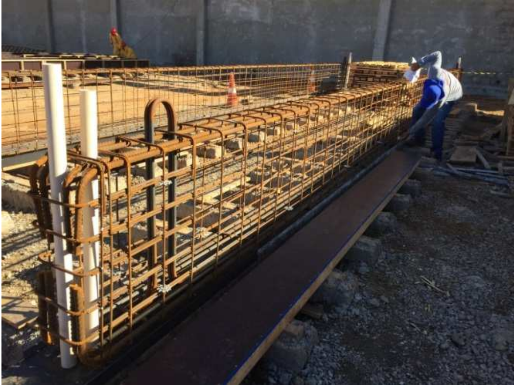
Figura 31-Viga com alças e armadura antes da concretagem
