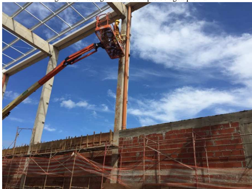
Figura 48-Passagem de tubulação de água pluvial
