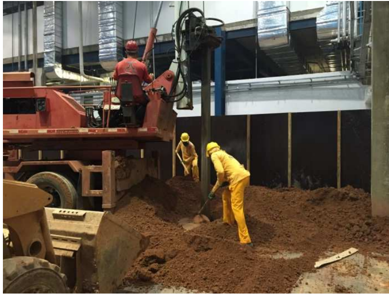
Figura 25-Perfuratriz executando o furo para estaca
