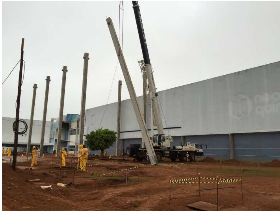
Figura 40-Montagem de pilar pré-moldado
