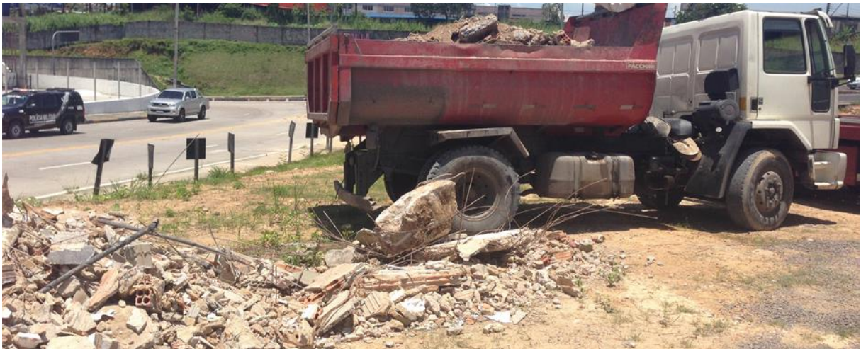
Figura 3 – Descarte irregular de entulho
