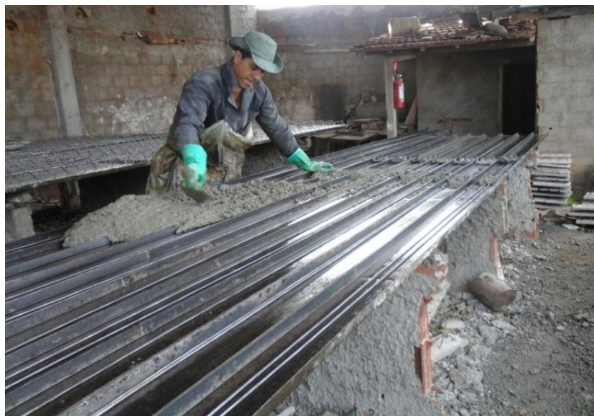
Figura 17 – Concreto colocado nas fôrmas
