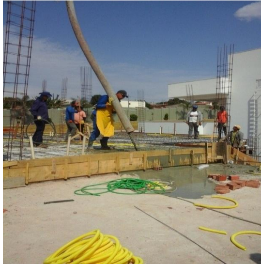
Figura 13 – Concretagem
