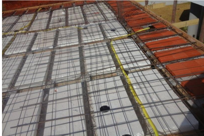
Figura 27 – Armadura de distribuição adicionada na obra
