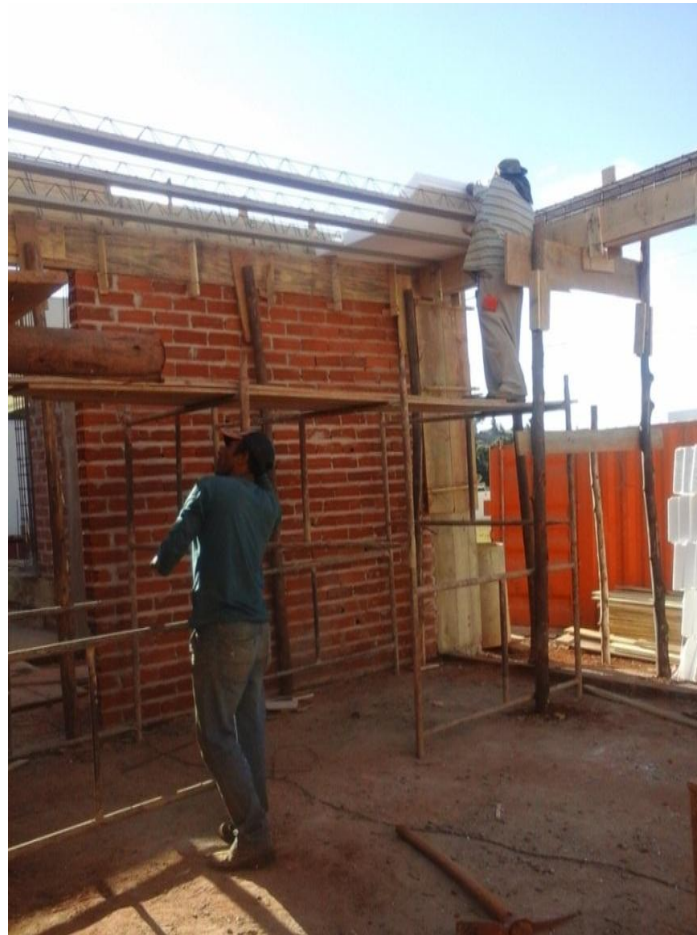
Figura 24 – Montagem das vigotas e EPS
