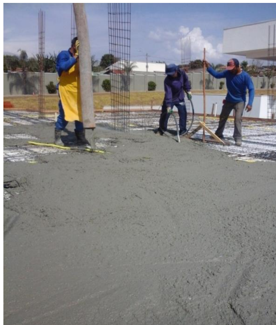
Figura 28 – Concretagem da laje
