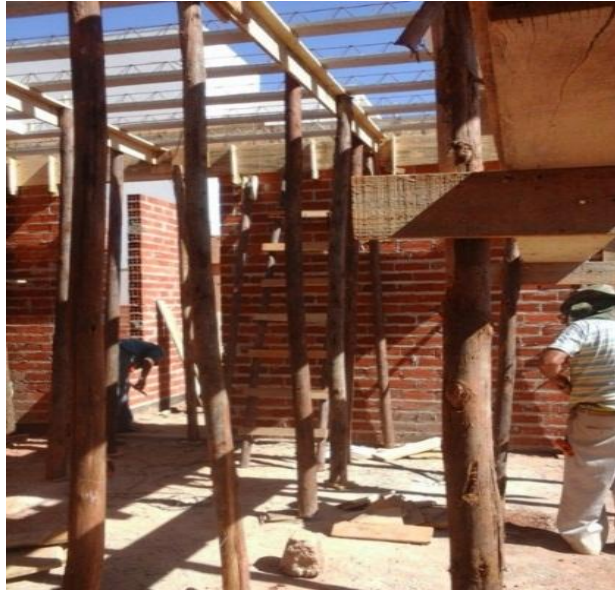
Figura 11- Escoras de madeiras
