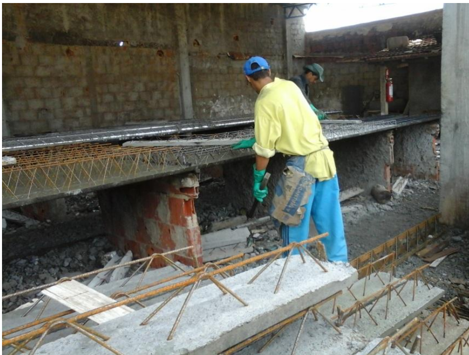
Figura 19 – Adensamento das treliças
