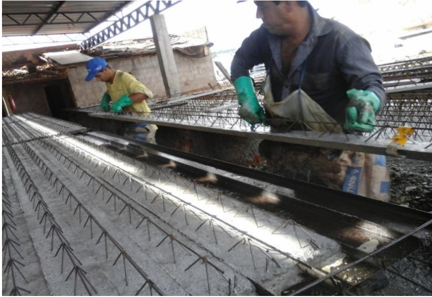
Figura 20 – Retirada da treliça da fôrma
