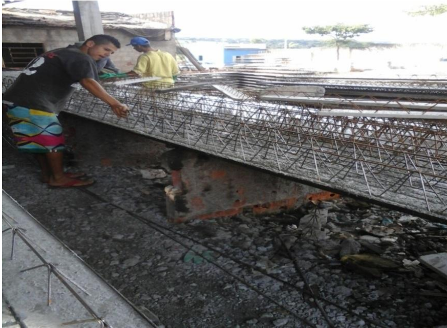
Figura 18 – Concretagem da treliça
