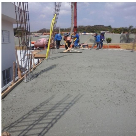
Figura 30 – Capa da laje concretada
