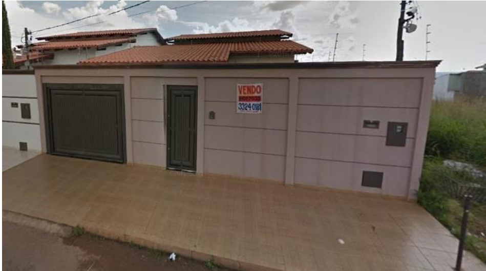
Figura 22: Vista da fachada do imóvel avaliando
