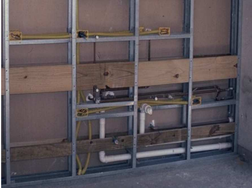
Figura 23: Modelo de instalação Hidráulica
