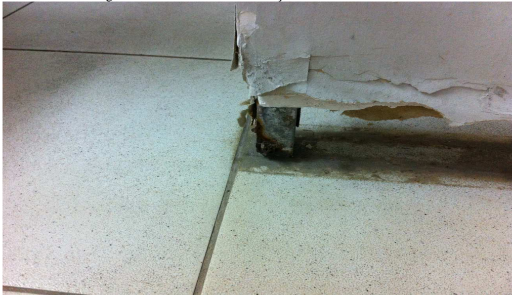
Figura 51: Cozinha/Área de Serviço – Parede na vista lateral
