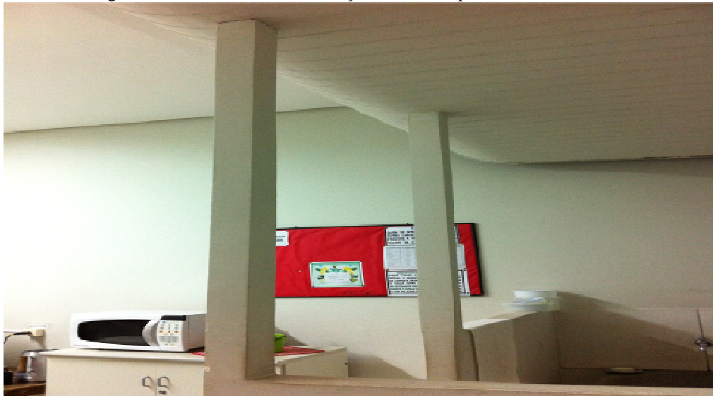
Figura 47: Cozinha/Área de Serviço – colunas e paredes de acartonado
