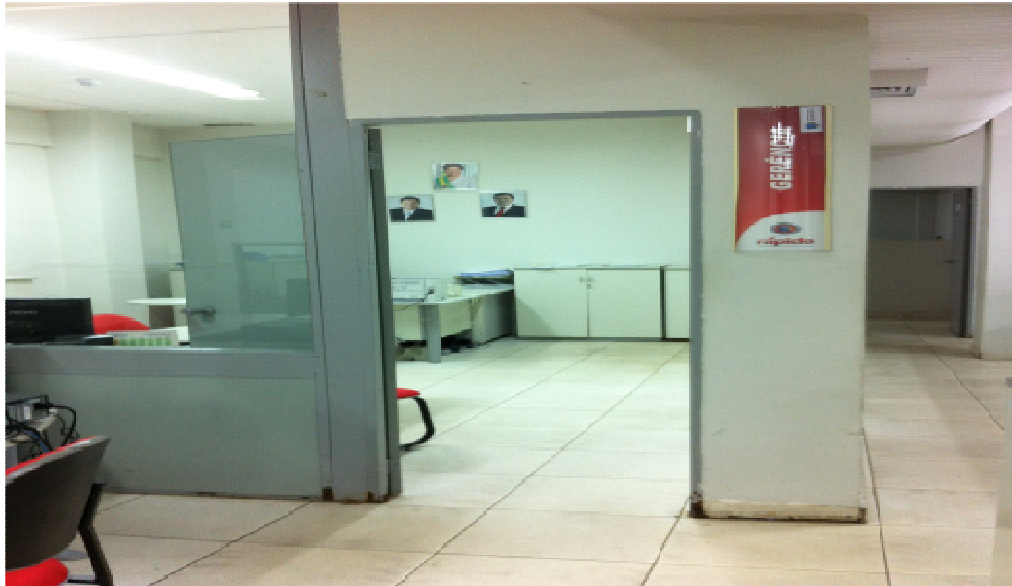
Figura 43: Ambiente de uso geral – Visão geral da parede de gesso
