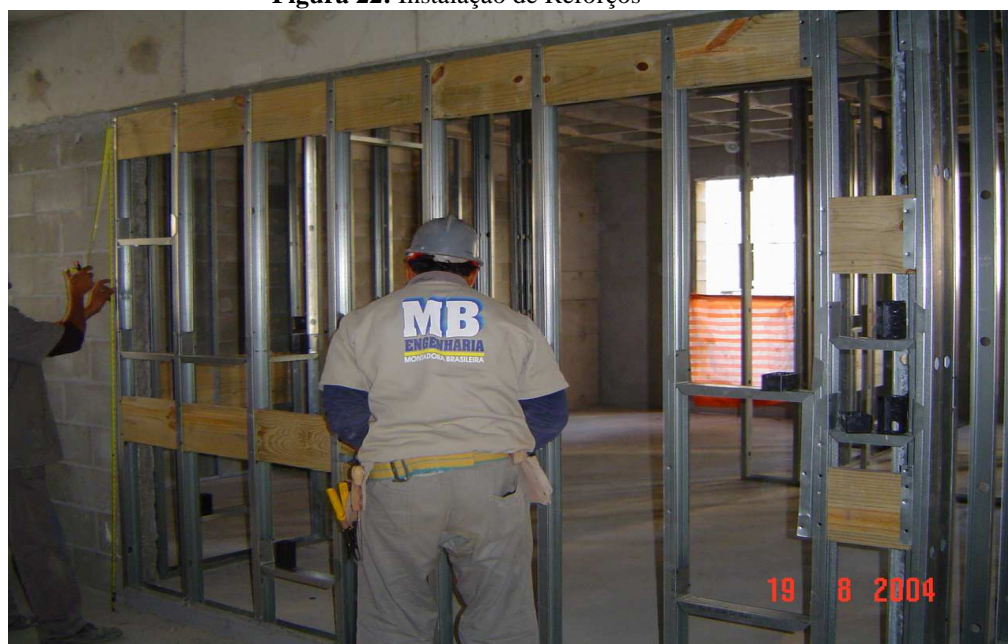
Figura 22: Instalação de Reforços
