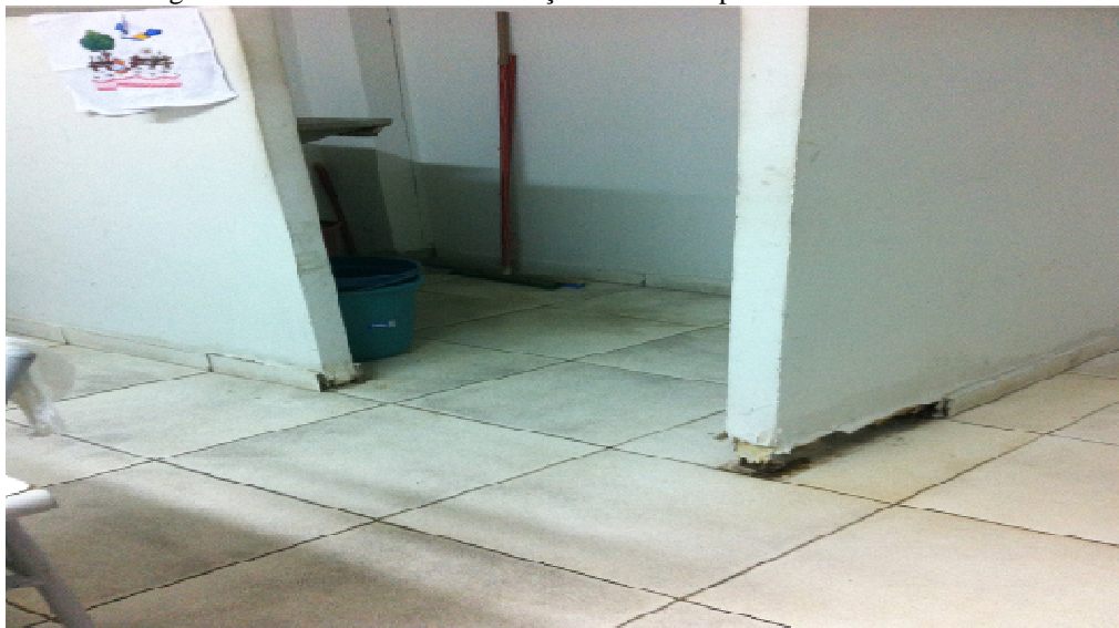
Figura 48: Cozinha/Área de Serviço – colunas e paredes de acartonado
