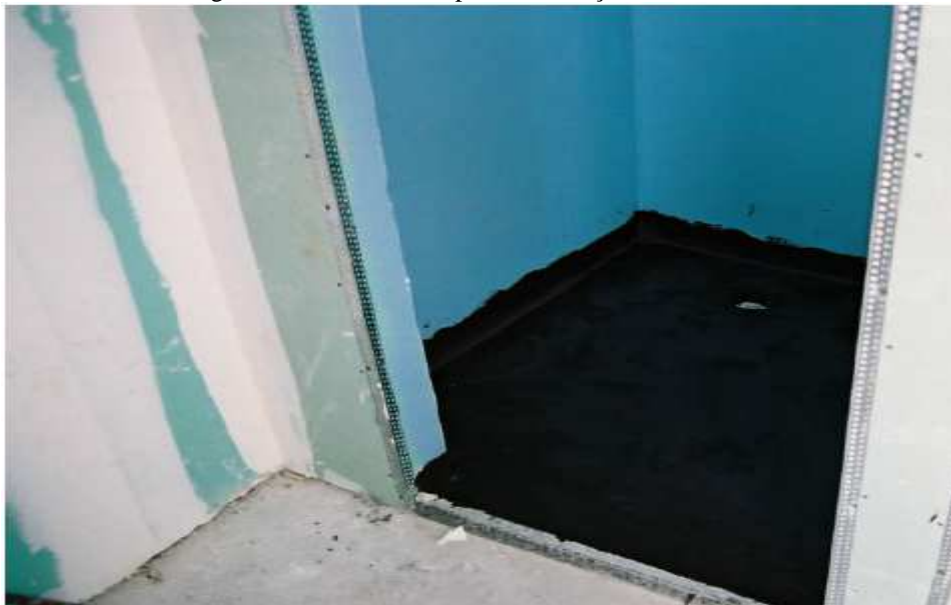
Figura 42: Modelo de impermeabilização em banheiro
