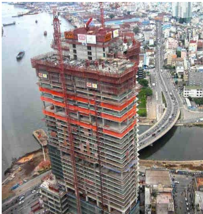
Figura 29 – Exemplo de edifício com o sistema de painéis FUVI
