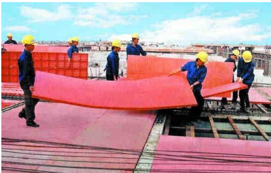
Figura 28 – Placas de formas para concreto HDPE
