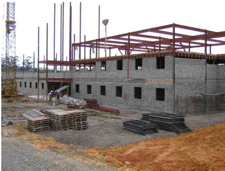
Figura 32 – Exemplo de construção com o uso de termobloco
