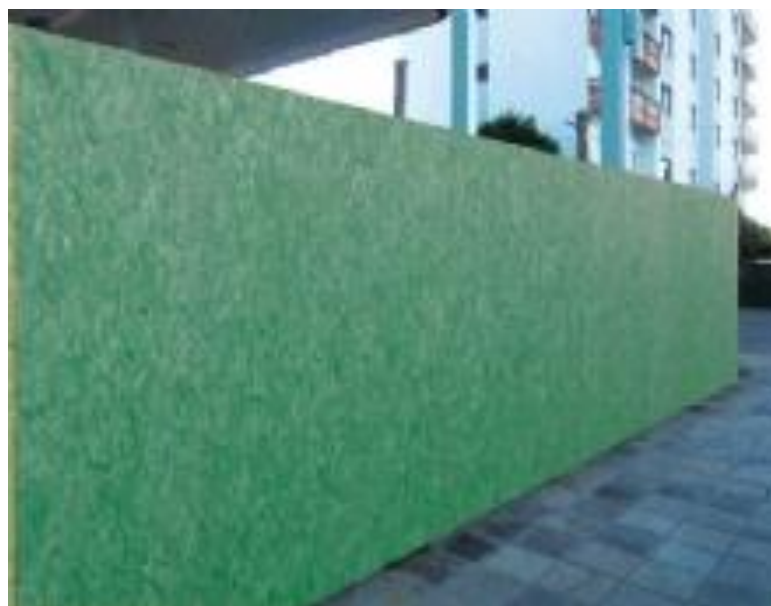
Figura 12 - Madeirite usado no canteiro de obra.
