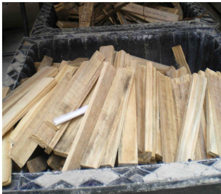
Figura 43 - Pedacos de madeira para marcação da numeração dos tipos de barras de aço
