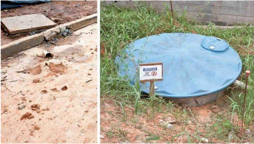
Figura 25 - Exemplo de coleta da água da chuva em canteiro de obras.
