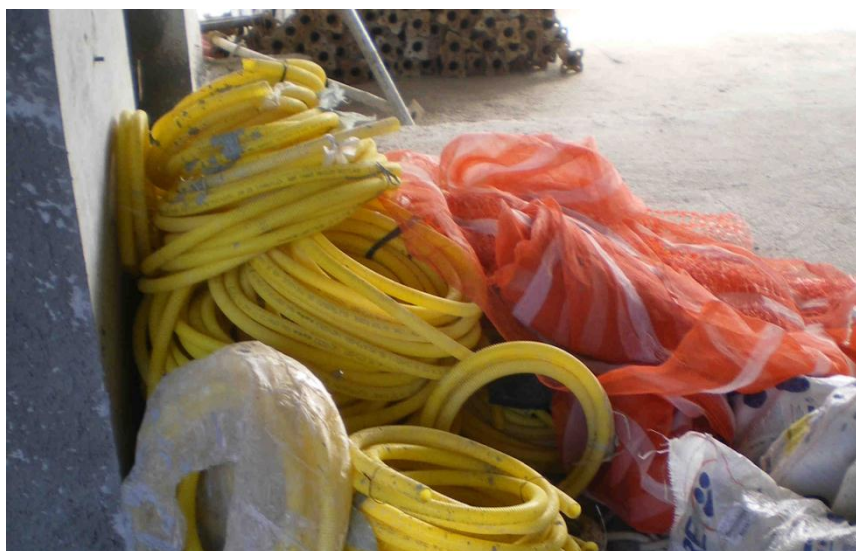
Figura 41 - Utilização de eletrodutos provenientes de sobras das outras obras da empresa
