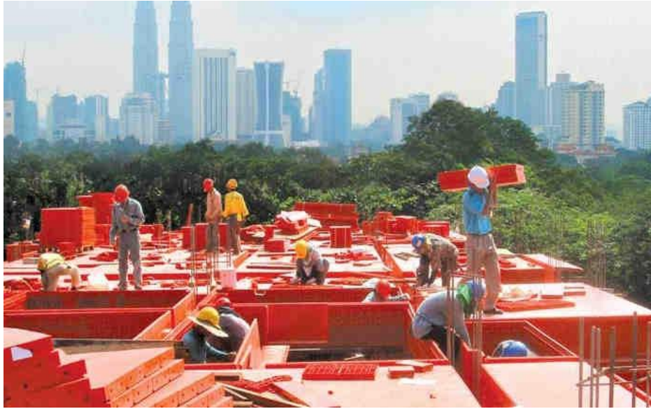
Figura 30 - Montagem da forma de edifício com o sistema FUVI
