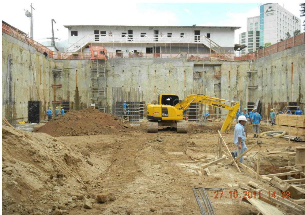
Figura 36 - Contenção do solo através do uso de paredes de diafragma
