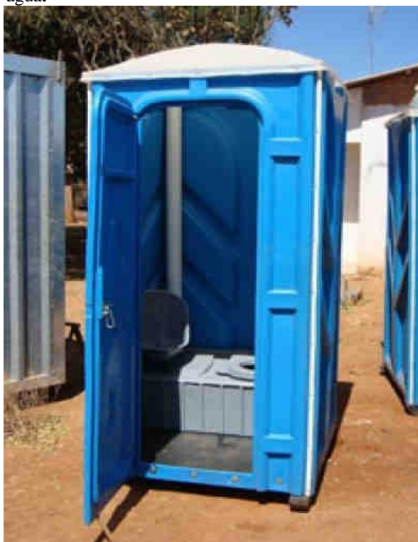
Figura 27 - Banheiro químico - a implantação desse sistema canteiro proporciona redução no consumo de água.
