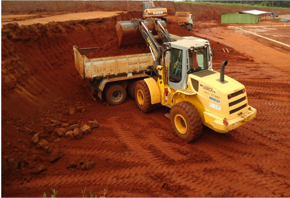
Figura 11 - Solo proveniente da terraplanagem.
