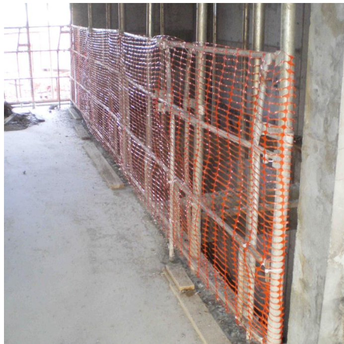
Figura 42 - Material que estava sem uso, e que virou guarda corpo metálico.
