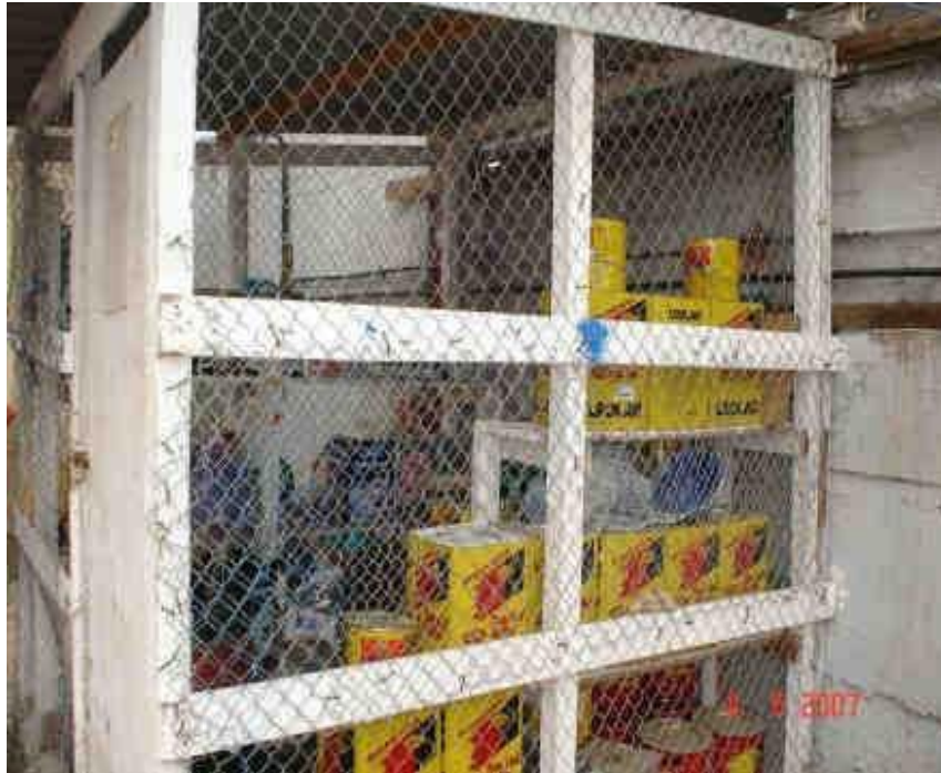
Figura 22 - Exemplo de estocagem de tintas dentro um de canteiro de obra
