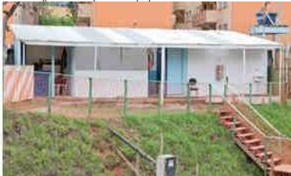
Figura 26 - Exemplo de instalação provisória com telhas translúcidas
