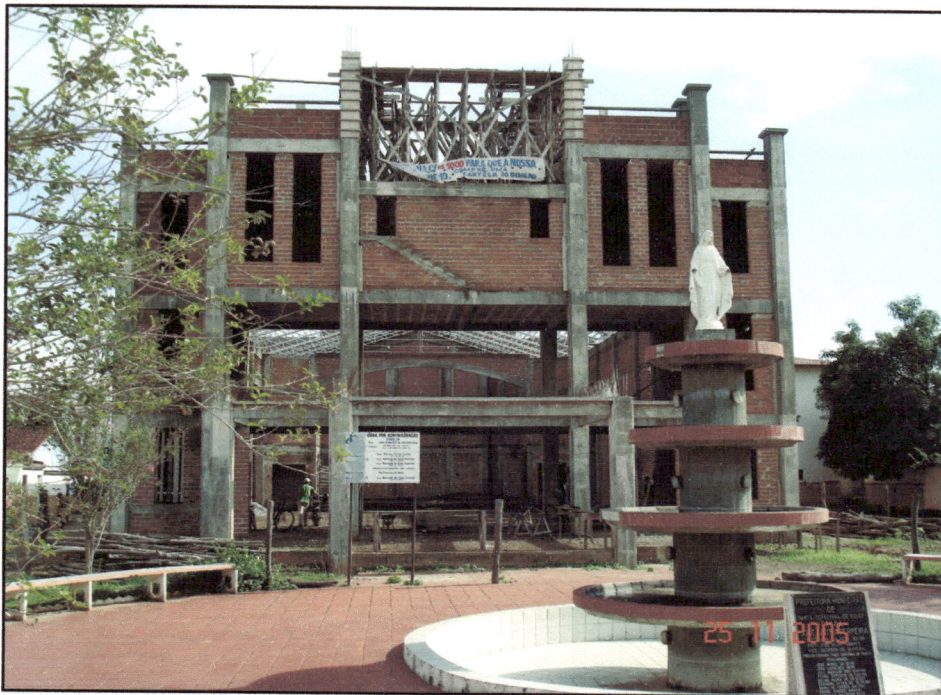
Obra da Igreja de Santa Terezinha de Goiás (em execução). Foto: Kennedy da Silva Correia, 25/11/2005.
