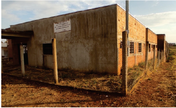
Figura 3: Futura sede da Associação Goianiense de Deficientes Físicos (AGODEF)
