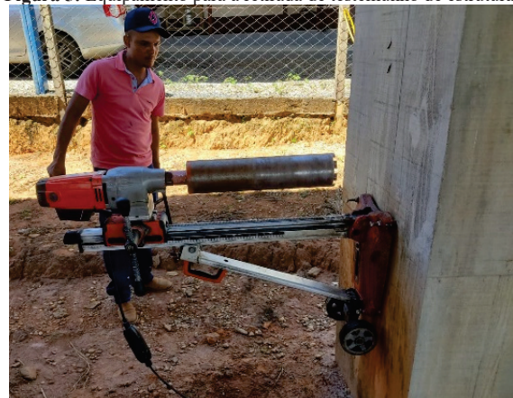
Figura 5: Equipamento para a retirada de testemunho de estrutural
