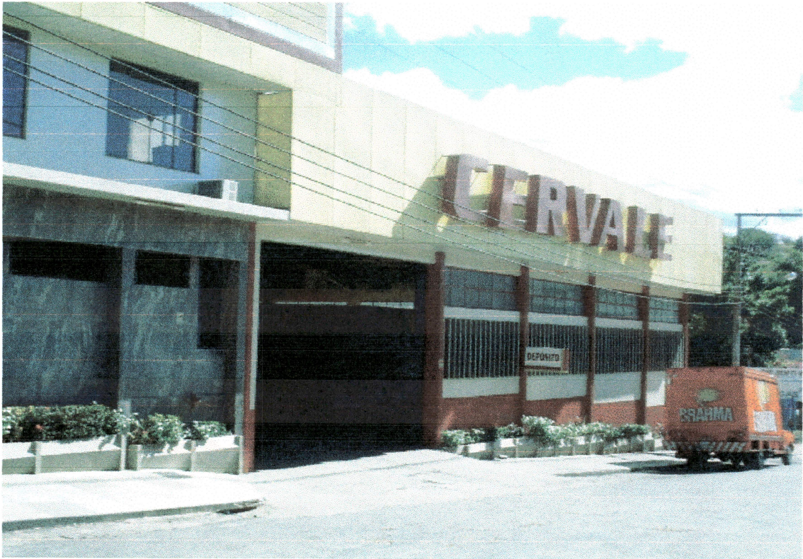
Anexo II – Entrada área operacional
