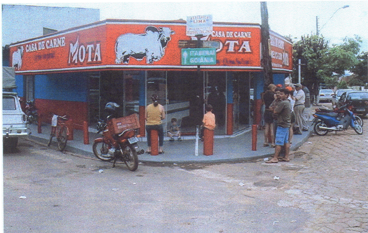
Casa de Carne Mota depois da reestruturação. (2005)
