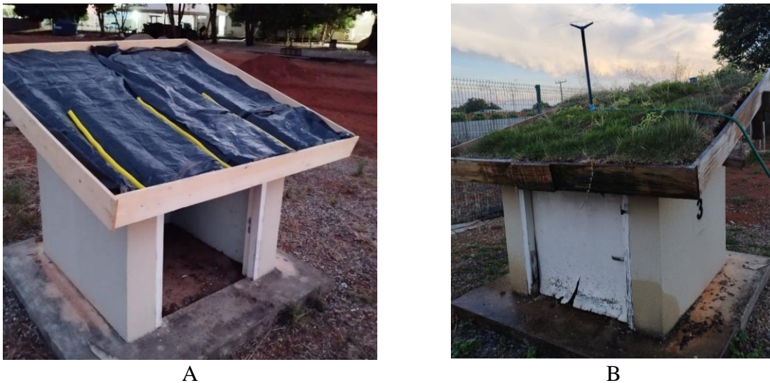
Figura 5 – (A) Montagem e (B) finalização do telhado verde na célula teste.
