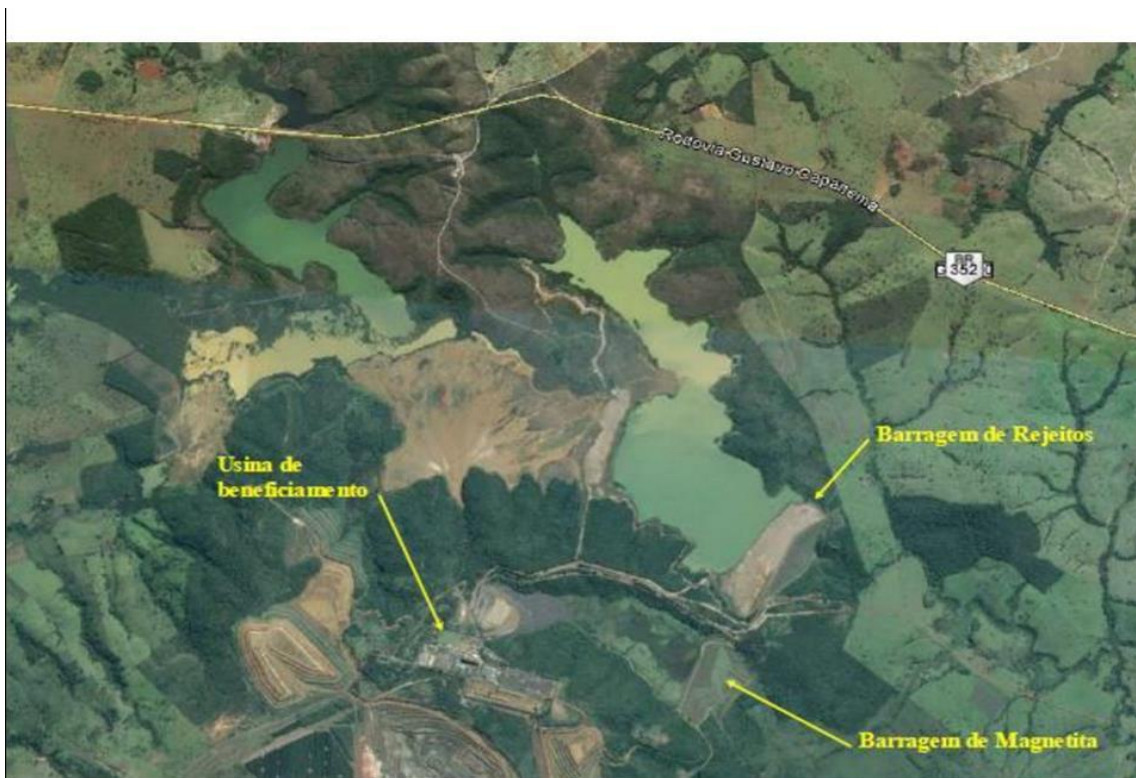
Mapa 4- Barragem de Rejeitos da Vale em Catalão/GO
