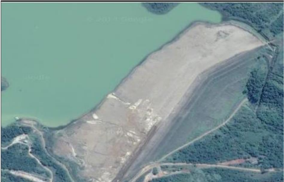
Foto 2: Barragem de Rejeitos da Vale na Fazenda Chapadão.
