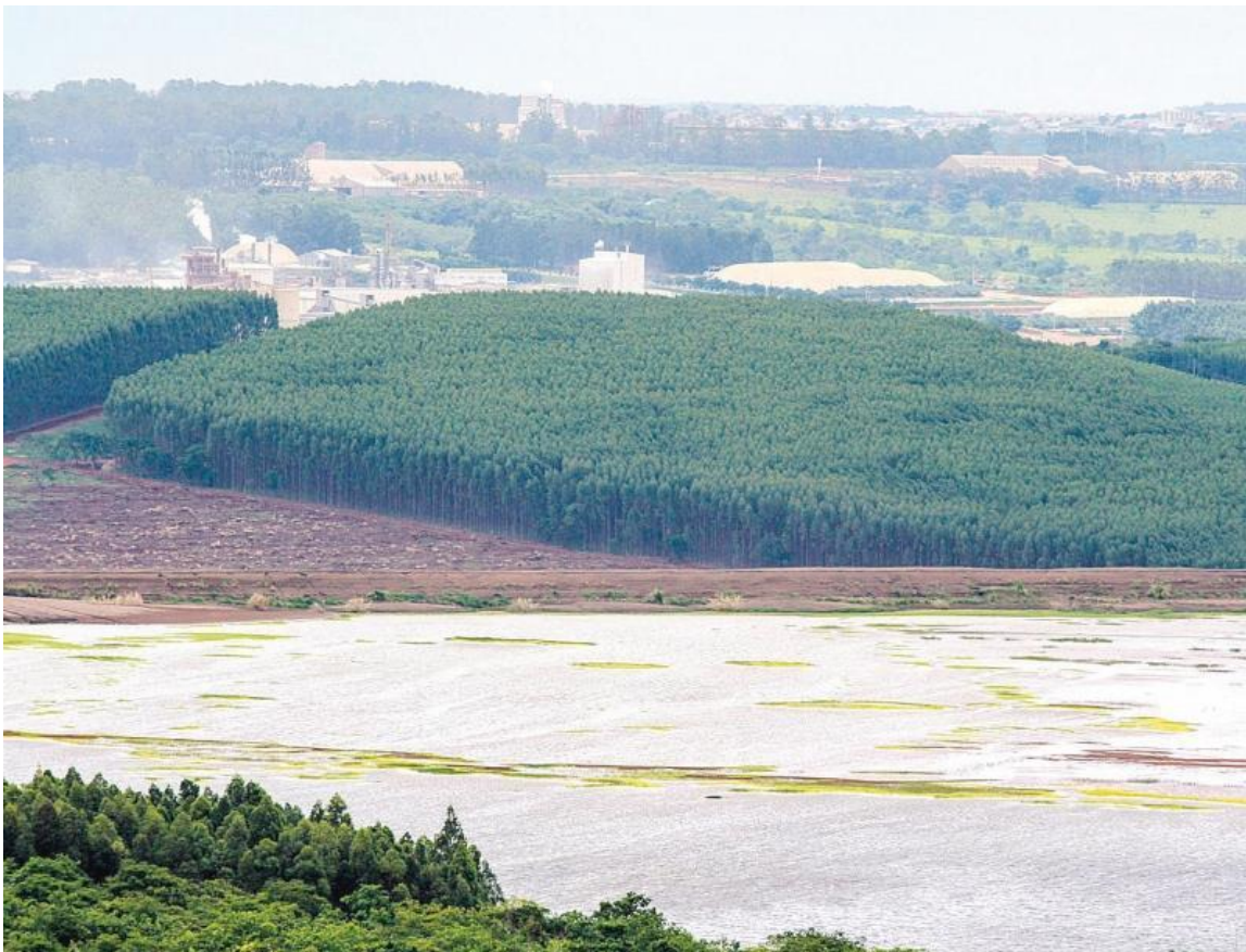
Foto 1: Barragem de Rejeitos da Vale Fertilizantes
