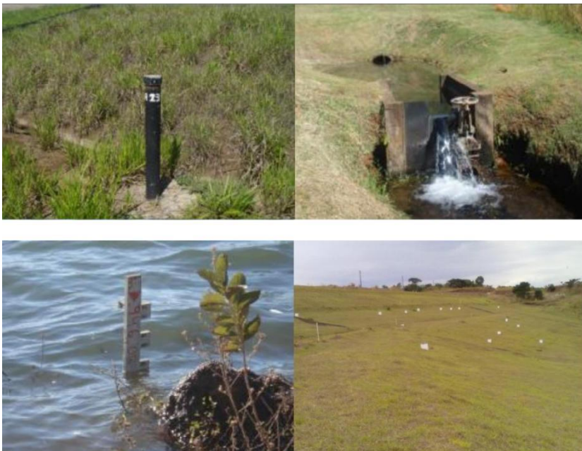
Foto 4: Equipamentos utilizados na barragem de rejeitos da Vale
