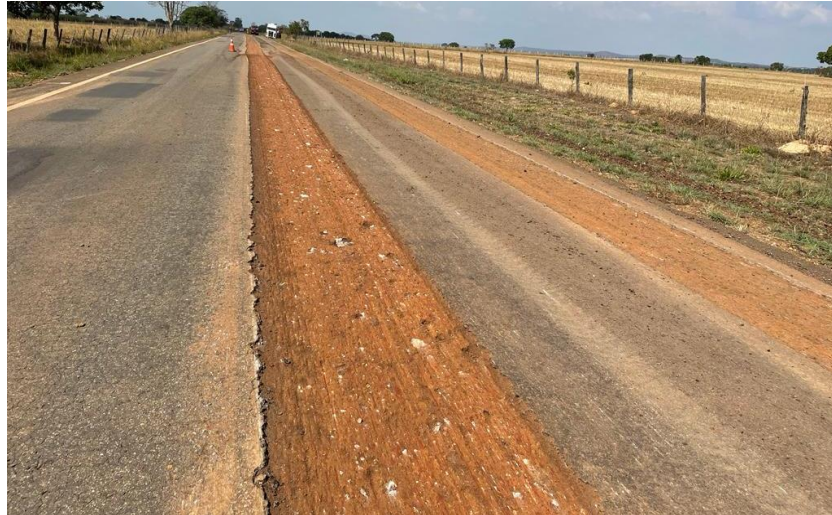
Figura 10: Via após corte de retirada do revestimento e remoção de resíduos
