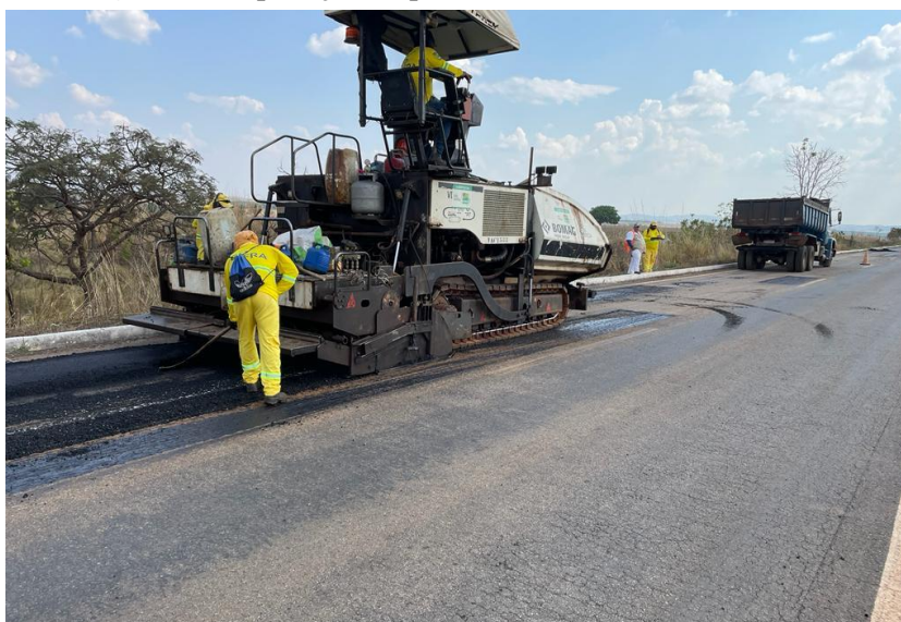
Figura 12: Aplicação da primeira camada do revestimento
