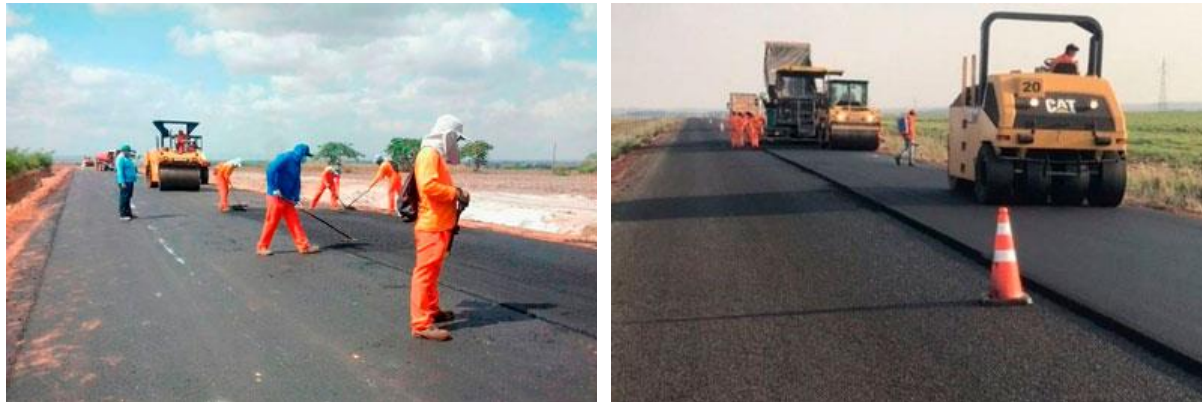
Figura 4: Processo de execução do concreto betuminoso usinado a quente CBUQ
