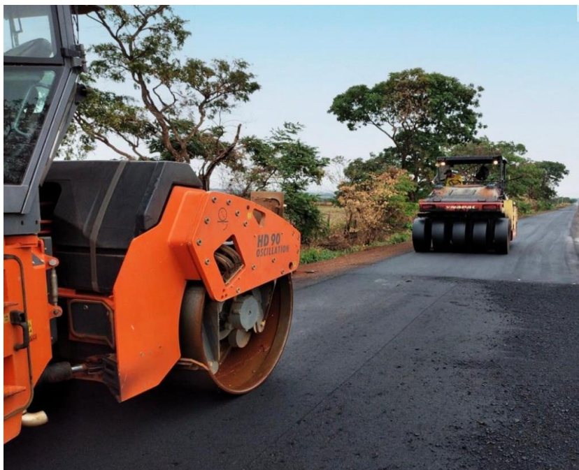
Figura 15: Compactação do revestimento
