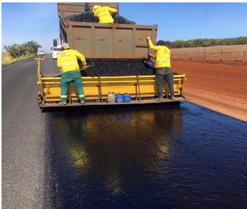
Figura 14: Aplicação final do CBUQ
