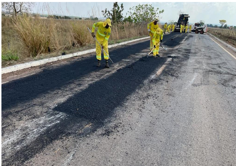
Figura 13: Regularização e nivelamento manual do revestimento
