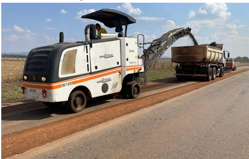
Figura 8: Fresadora de asfalto.
