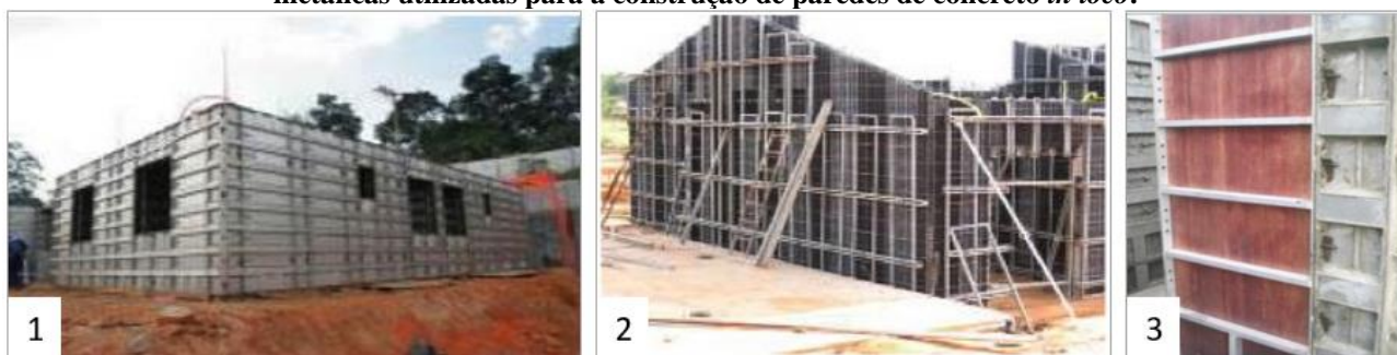
Figura 1 – (A) Exposição de formas metálicas; (B) Montagem de formas metálicas; (C) Detalhamento das formas metálicas utilizadas para a construção de paredes de concreto in loco .
